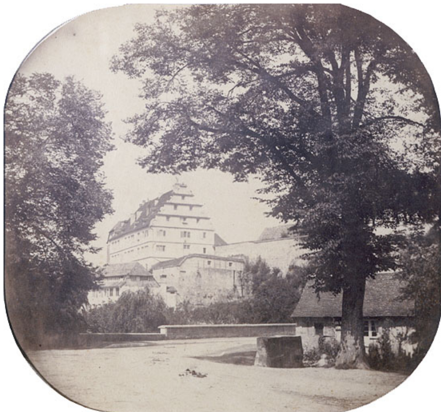
Fortifications de l'ensemble fortifié et maison des Courtisans, années 1860-1870. 25, Montbéliard cour du Château
