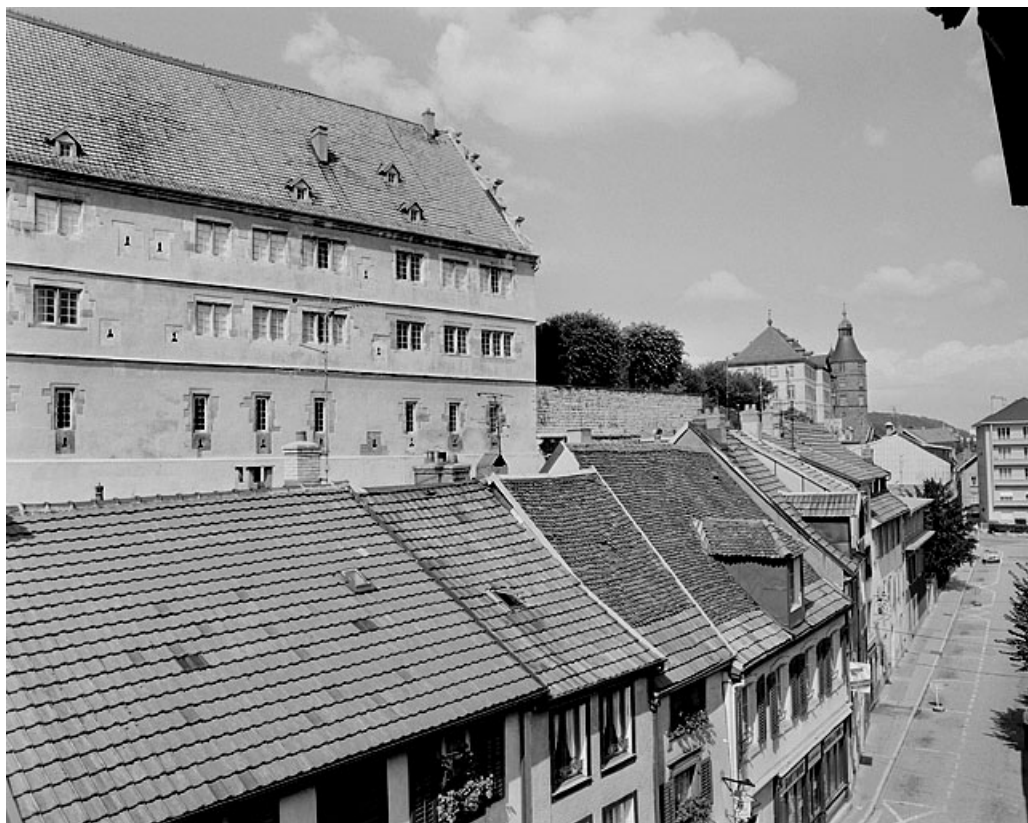
Façade sud et rue de Belfort.
