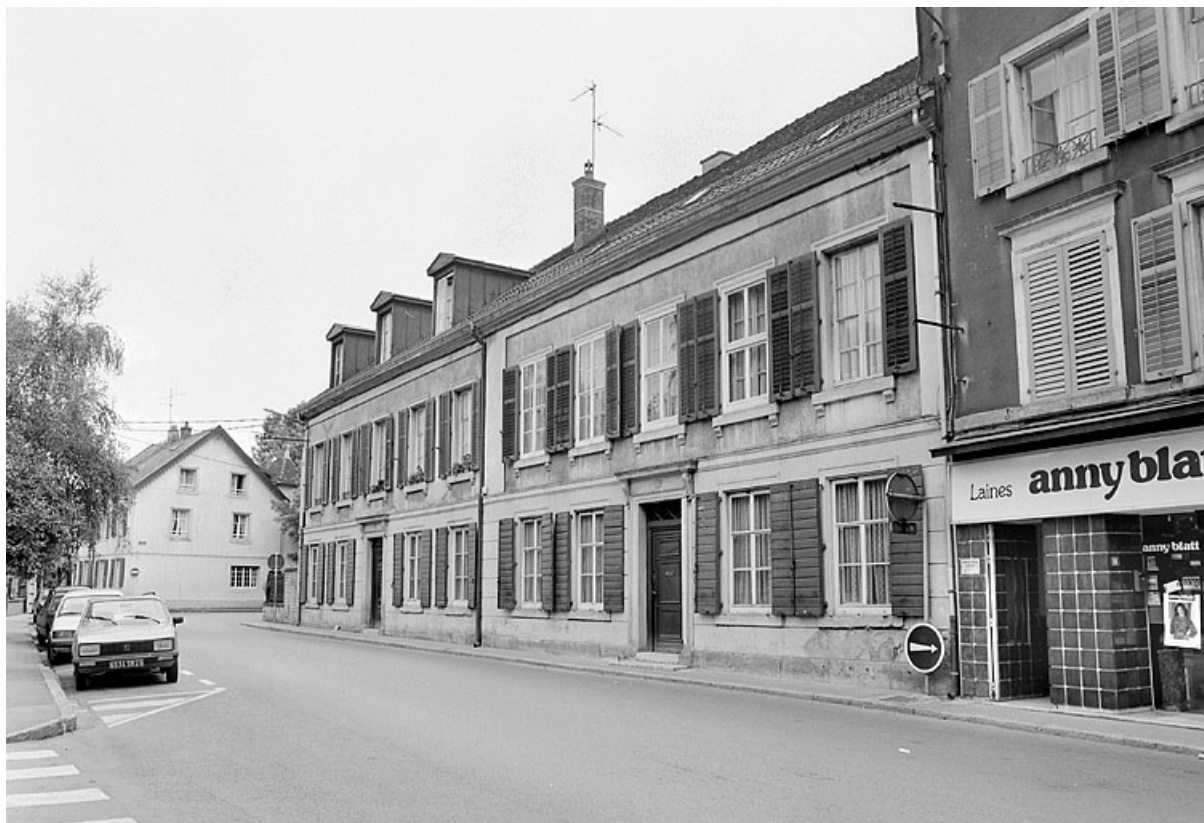
Vue d'ensemble de la façade sur rue avec celle du numéro 18. 25, Montbéliard, 20 rue Viette
