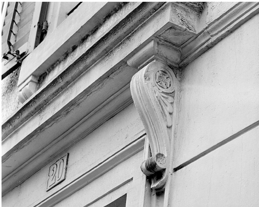
Porte d'entrée, détail d'une console supportant la corniche.
