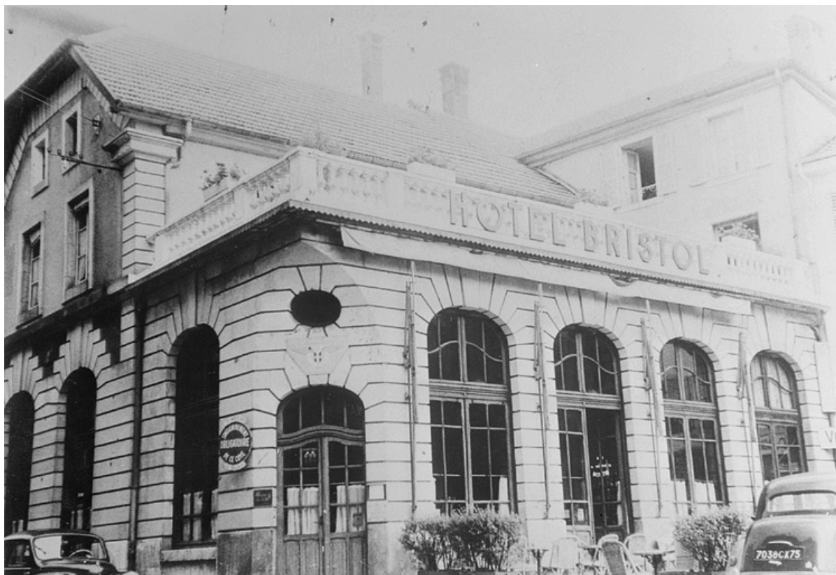
Vue extérieure du Grand Café, vers 1940-1950. 25, Montbéliard, 4, 2 rue de Velotte
