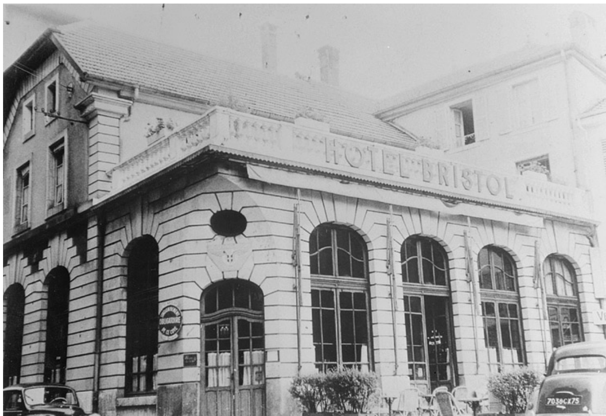
Vue extérieure du Grand Café, vers 1940-1950. 25, Montbéliard, 4, 2 rue de Velotte
