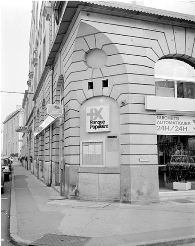
Détail de l'angle de l'ancien Grand Café. 25, Montbéliard, 4, 2 rue de Velotte
