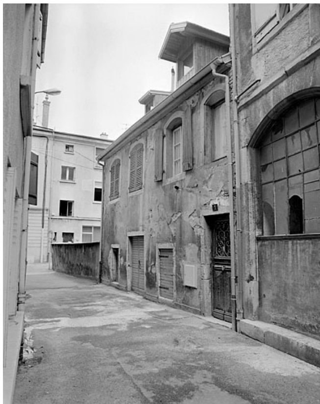
Façade sur la rue des Tanneries.
