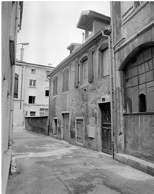
Façade sur la rue des Tanneries.
