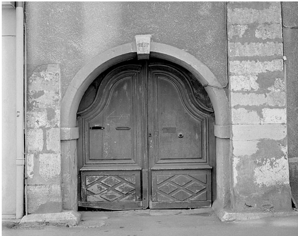
Porte cochère sur la rue de la Sous-Préfecture. Porte percée en 1667 et garnie d'une menuiserie du 18e siècle. 25, Montbéliard, 4 rue de la Sous-Préfecture
