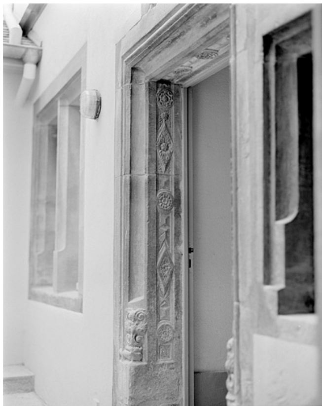
Porte sur cour du premier corps de bâtiment, piédroit de gauche. 25, Montbéliard, 11 rue de la Sous-Préfecture
