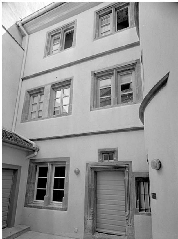
Façade sur cour du premier corps de bâtiment.
