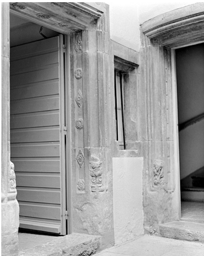
Porte sur cour du premier corps de bâtiment, piédroit de droite. 25, Montbéliard, 11 rue de la Sous-Préfecture
