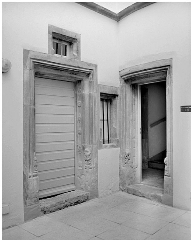
Porte du premier corps de bâtiment et porte de la tour d'escalier.
