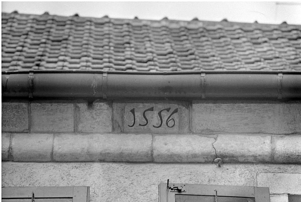
Façade sur rue, détail de la corniche.
