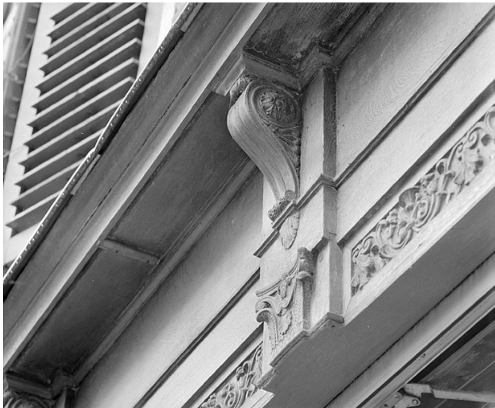
Façade sur rue, vestige de l'ancienne devanture.
