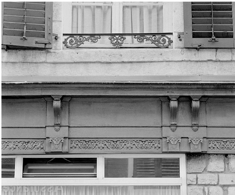
Façade sur rue, vestige de l'ancienne devanture.
