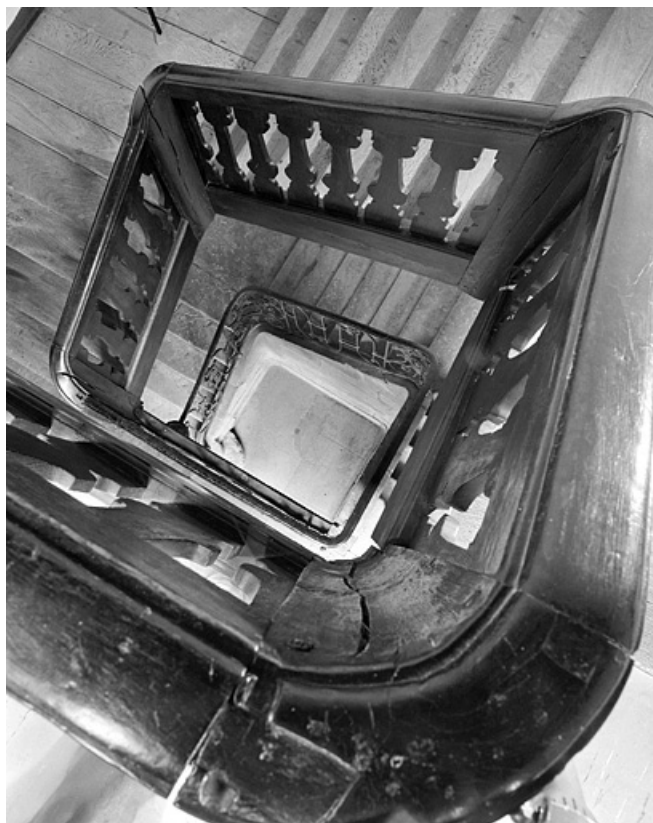
Escalier vu du deuxième étage.
