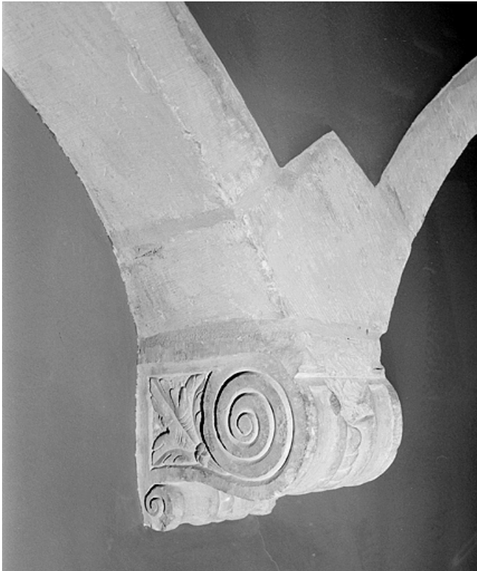
Détail du corbeau soutenant la retombée centrale de l'arc double de la pièce principale au premier étage. 25, Montbéliard, 5 rue de la Sous-Préfecture
