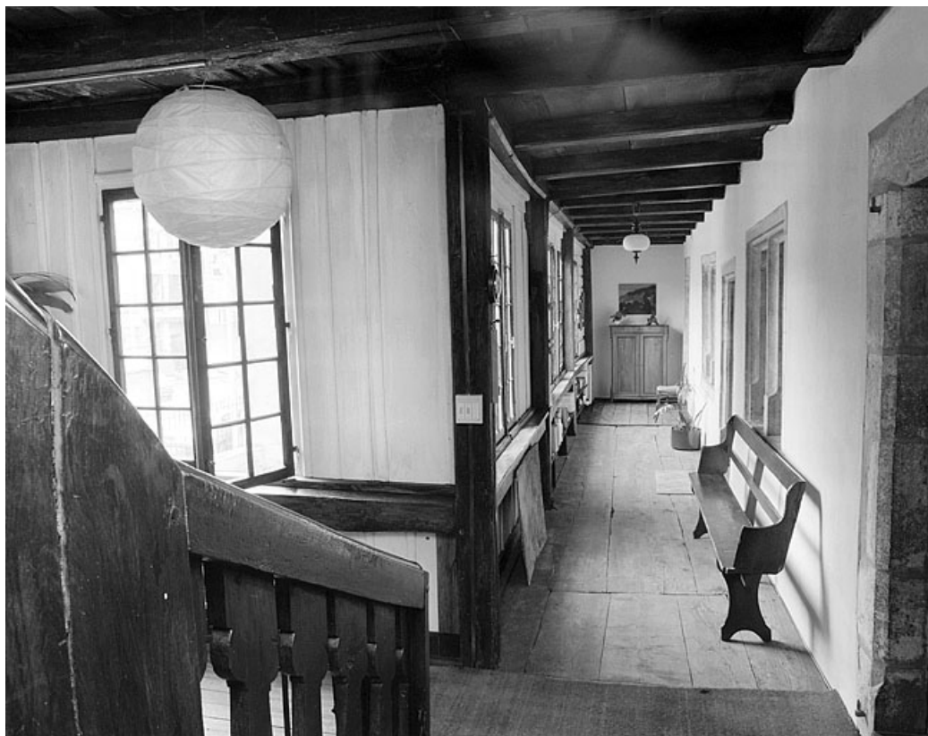
Galerie de distribution du premier étage. 25, Montbéliard, 5 rue de la Sous-Préfecture
