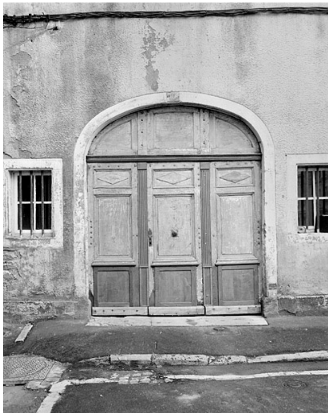
Portail de la maison édiflée à l'emplacement de l'ancienne grange. 25, Montbéliard, 5, 7 place Saint-Martin
