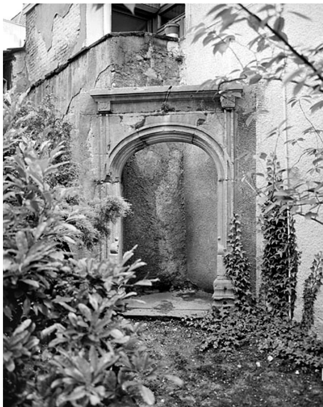
Portail provenant d'une maison détruite rue du Château. 25, Montbéliard, 8 place Saint-Martin
