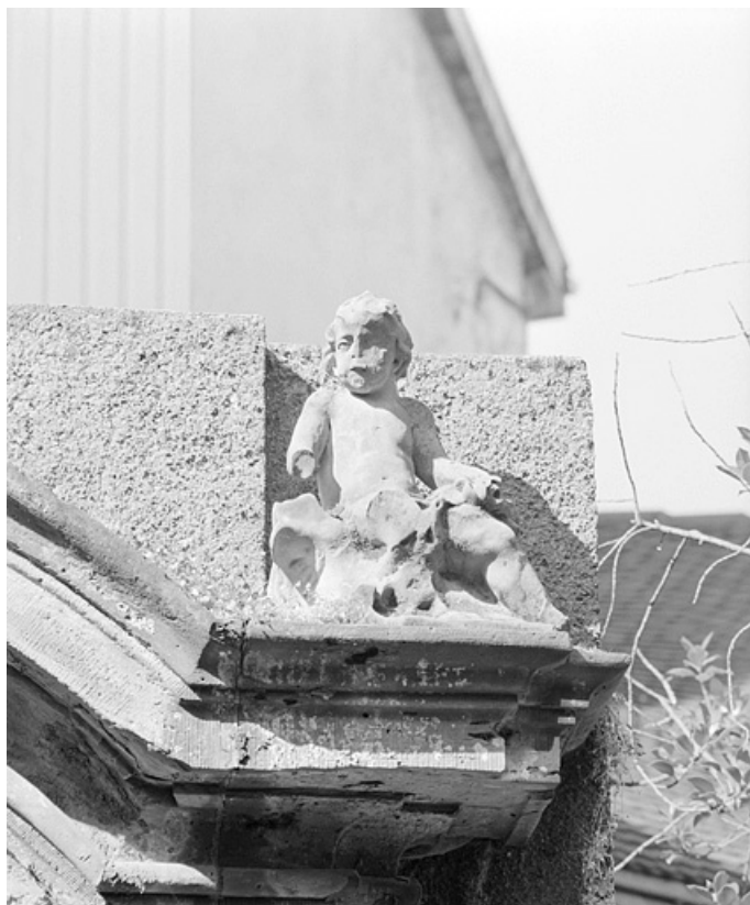
Portail provenant de l'hôtel 11, rue des Febvres, détail du putto de droite. 25, Montbéliard, 8 place Saint-Martin
