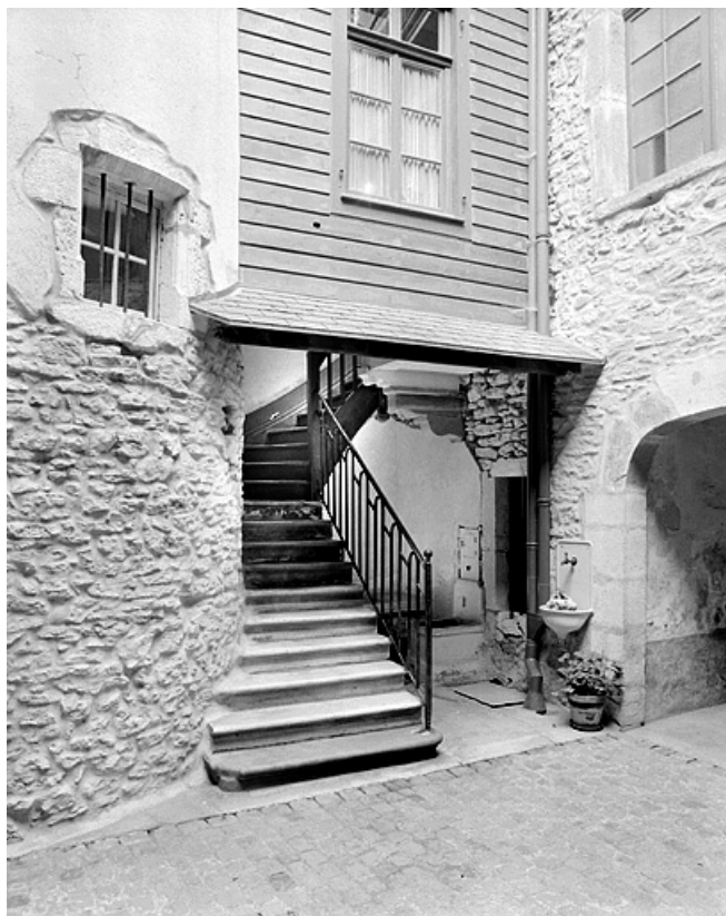
Escalier secondaire desservant le deuxième corps de bâtiment. 25, Montbéliard, 17 place Saint-Martin
