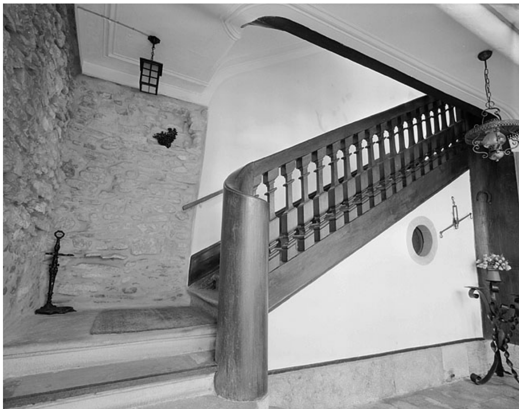
Escalier principal vu du rez-de-chaussée. 25, Montbéliard, 17 place Saint-Martin
