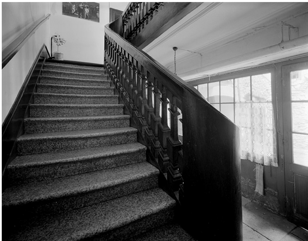
Escalier principal vu du premier repos. 25, Montbéliard, 17 place Saint-Martin
