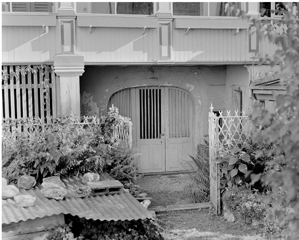
Porte ouvrant sur la deuxième cour, vue du jardin.
