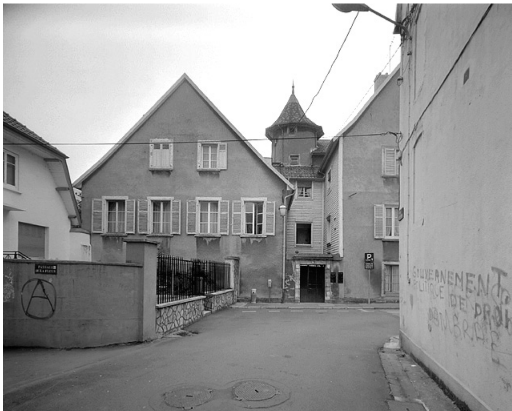
Deuxième corps de bâtiment, cour et tour d'escalier vus de la rue Laurillard. 25, Montbéliard, 15 place Saint-Martin
