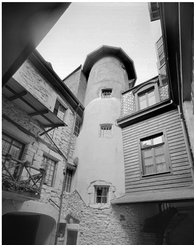
Tour d'escalier vue de la cour du numéro 17. 25, Montbéliard, 15 place Saint-Martin
