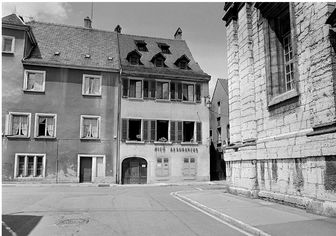
Façade principale sur la rue Saint-Martin.
