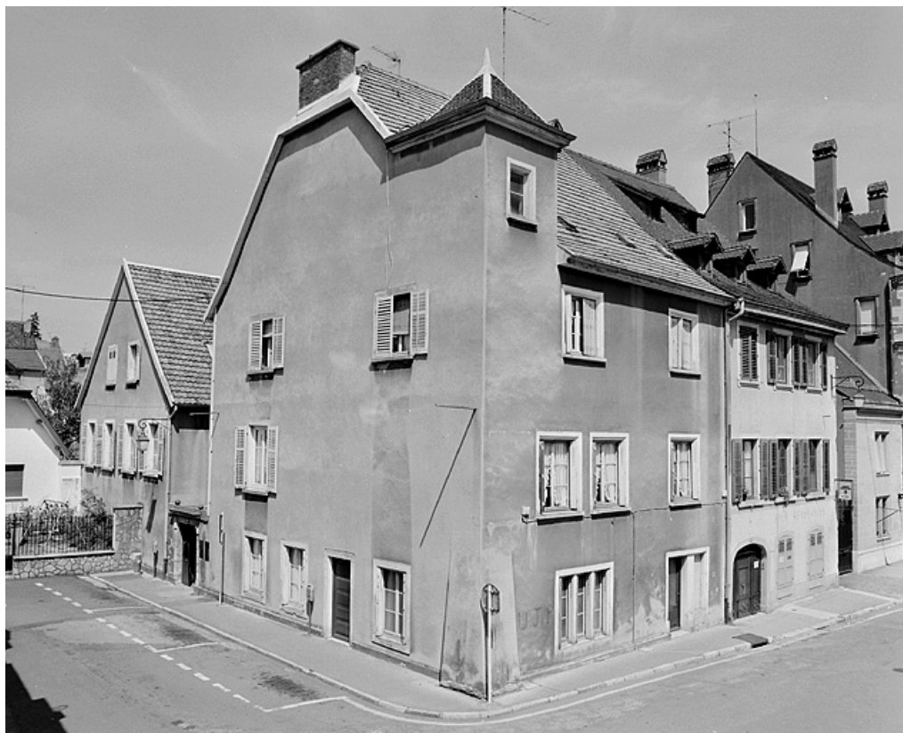
Vue d'ensemble des deux corps de bâtiment principaux.
