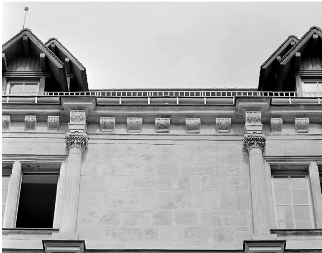
Façade sur la place, troisième étage, détail de l'ordre composite de la travée centrale. 25, Montbéliard, 21 place Saint-Martin
