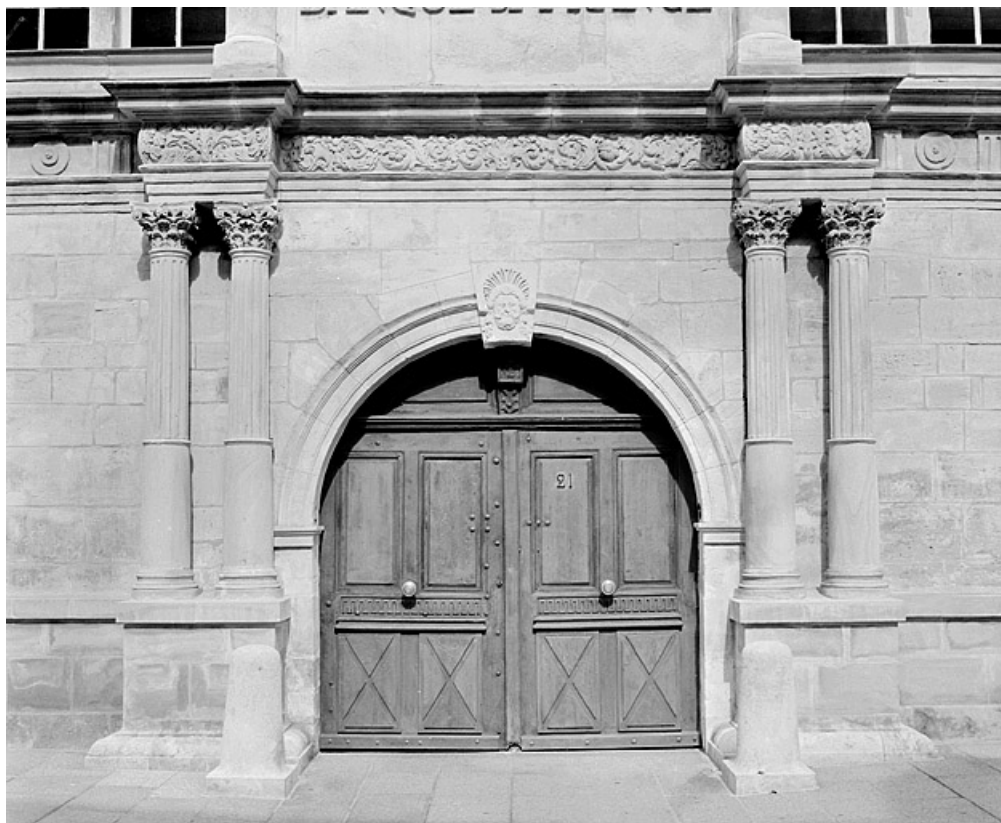
Façade sur la place, portail.
