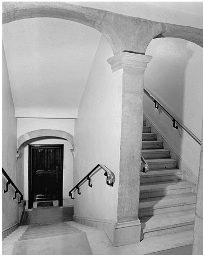
Escalier vu du palier du deuxième étage.
