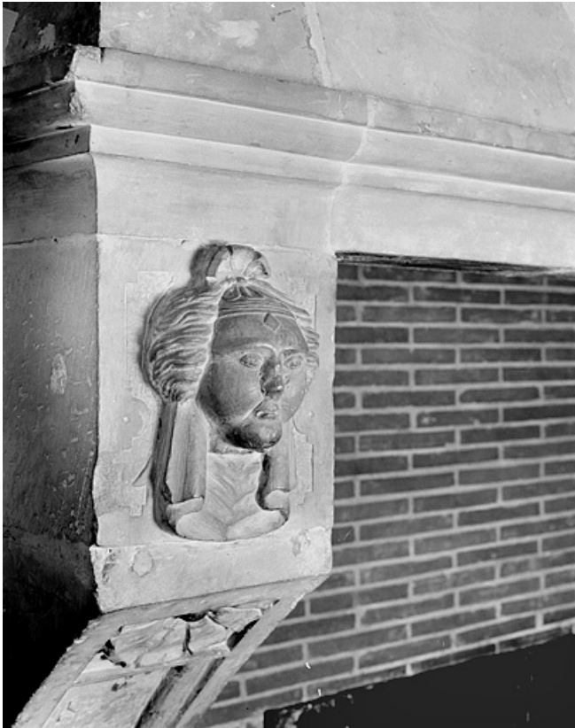
Première cheminée au deuxième étage, détail. 25, Montbéliard, 21 place Saint-Martin
