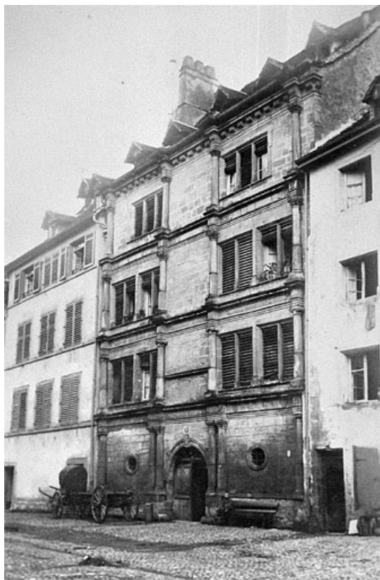
Façade sur la place Saint-Martin [avant la démolition des maisons mitoyennes], vers 1870-1880. 25, Montbéliard, 21 place Saint-Martin
