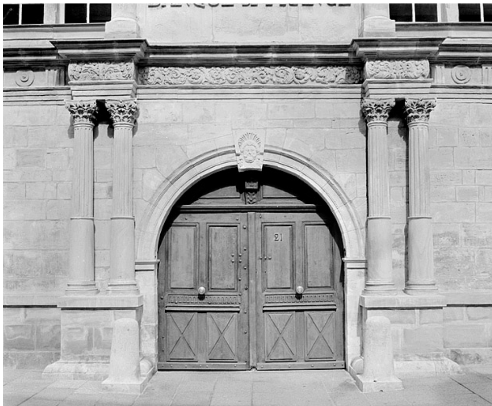
Façade sur la place, portail.
