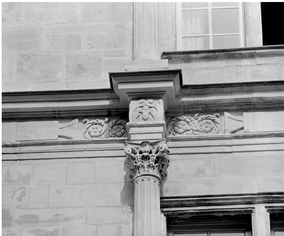
Façade sur la place, deuxième étage, chapiteau de l'ordre corinthien à droite de la travée centrale. 25, Montbéliard, 21 place Saint-Martin
