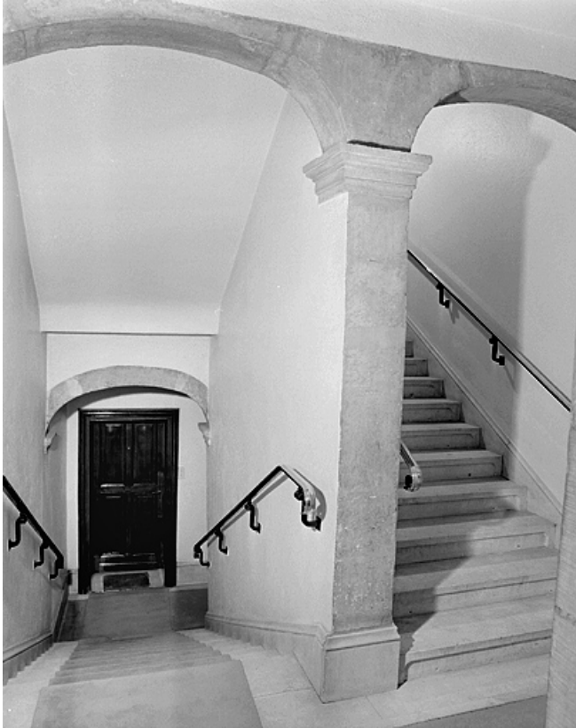
Escalier vu du palier du deuxième étage. 25, Montbéliard, 21 place Saint-Martin
