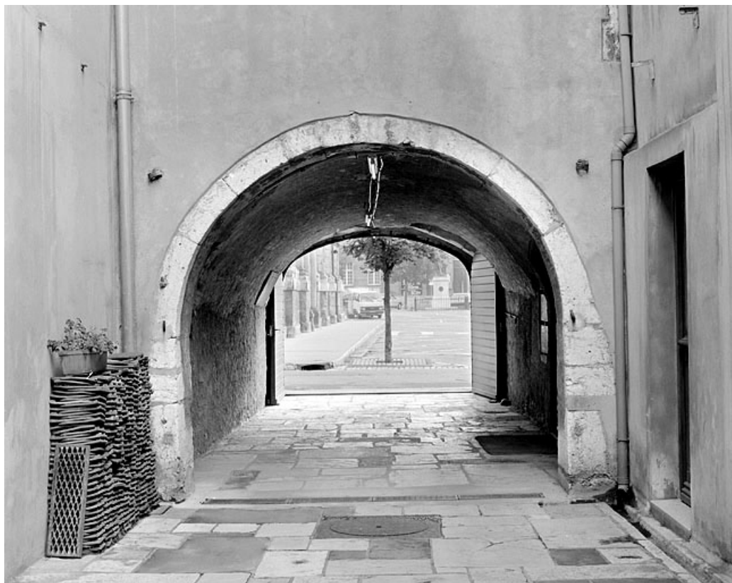
Passage cocher vu de la cour vers la place.
