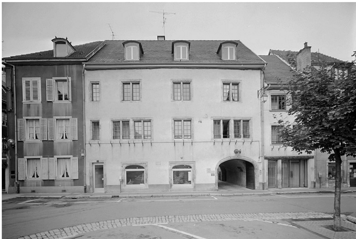
Façade sur la place de la maison de gauche.
