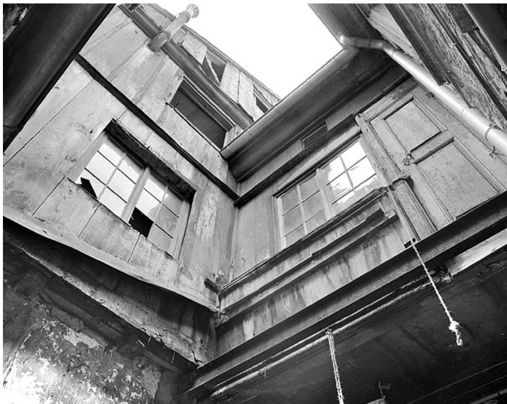
Cour. À gauche, cage d'escalier accolée au premier corps de bâtiment ; à droite, galerie de liaison. 25, Montbéliard, 10 rue Saint-Hippolyte
