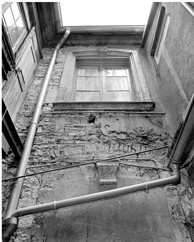
Façade sur cour du deuxième corps de bâtiment.
