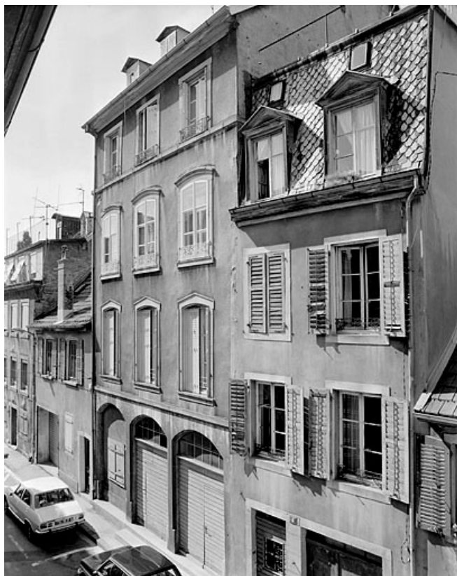
Façade sur la rue de la Planchette.
