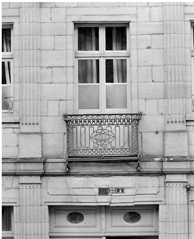
Façade sur rue. Fenêtre centrale du premier étage.
