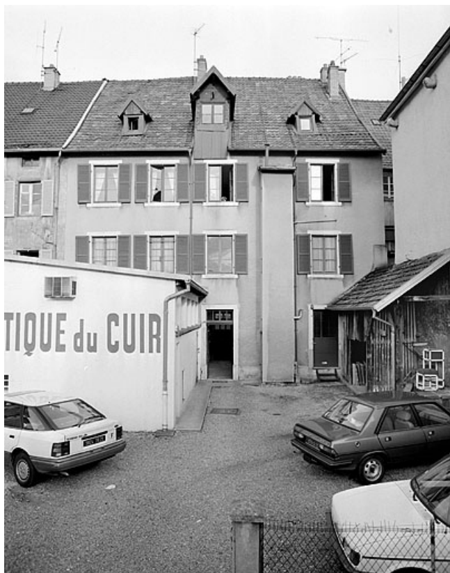
Façade sur cour.
