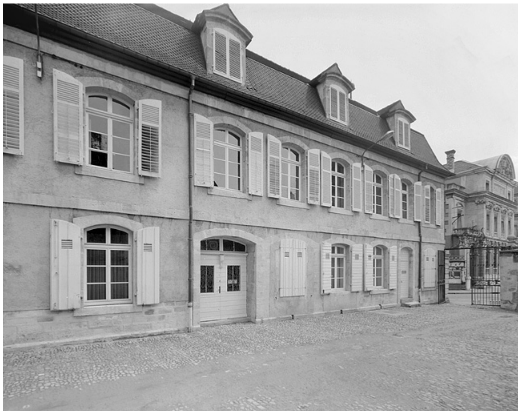
Façade sur cour de l'aile en retour.
