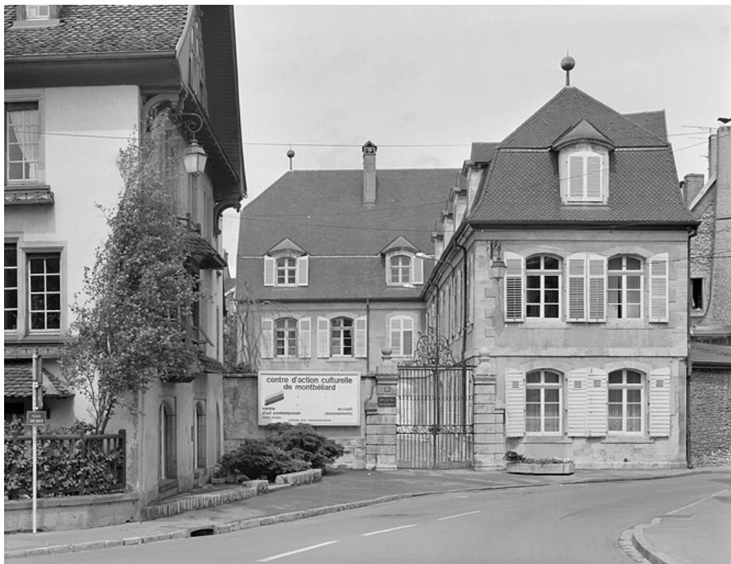
Vue d'ensemble depuis la place Saint-Martin. 25, Montbéliard, 54 rue Georges Clémenceau
