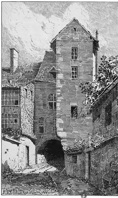
Le passage de la Fleur. Montbéliard, 1883. 25, Montbéliard, 34 rue Georges Clémenceau
