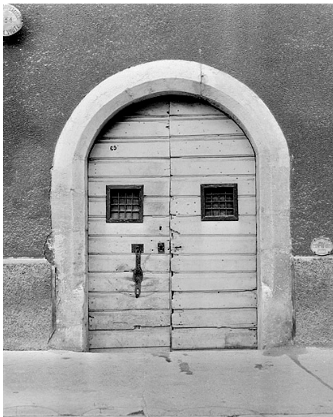
Façade sur rue. Porte de la cave haute.
