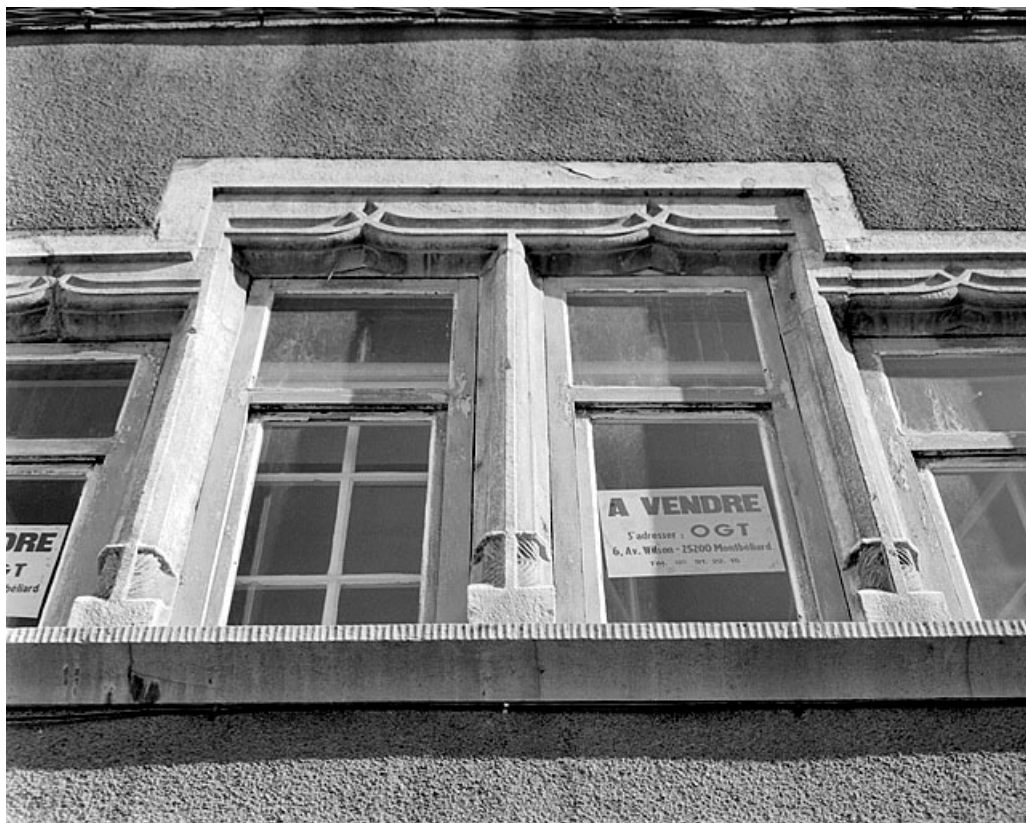
Façade sur rue. Fenêtre du premier étage, à gauche. 25, Montbéliard, 34 rue Georges Clémenceau
