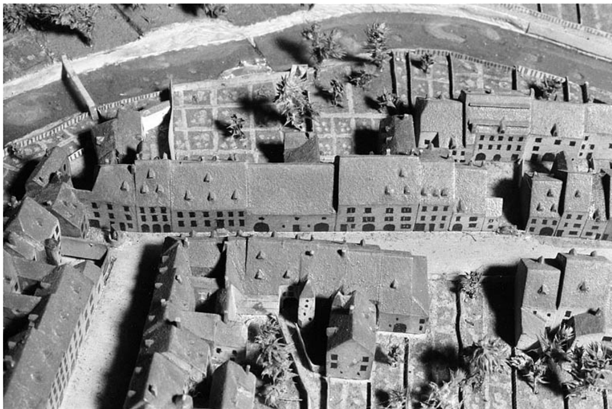
Façade sur rue (avec ses trois baies en anse de panier au rez-de-chaussée), 1823-1826. Extrait du plan-relief de 1823-1826, par R.G.I. Wild, échelle 1:1000 (conservé au Musée historique du Vieux Montbéliard). 25, Montbéliard, 33 rue Georges Clémenceau
