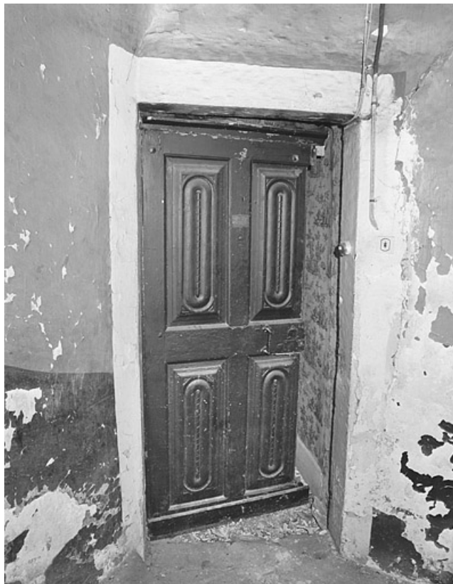
Porte du deuxième étage dans la tour d'escalier.
