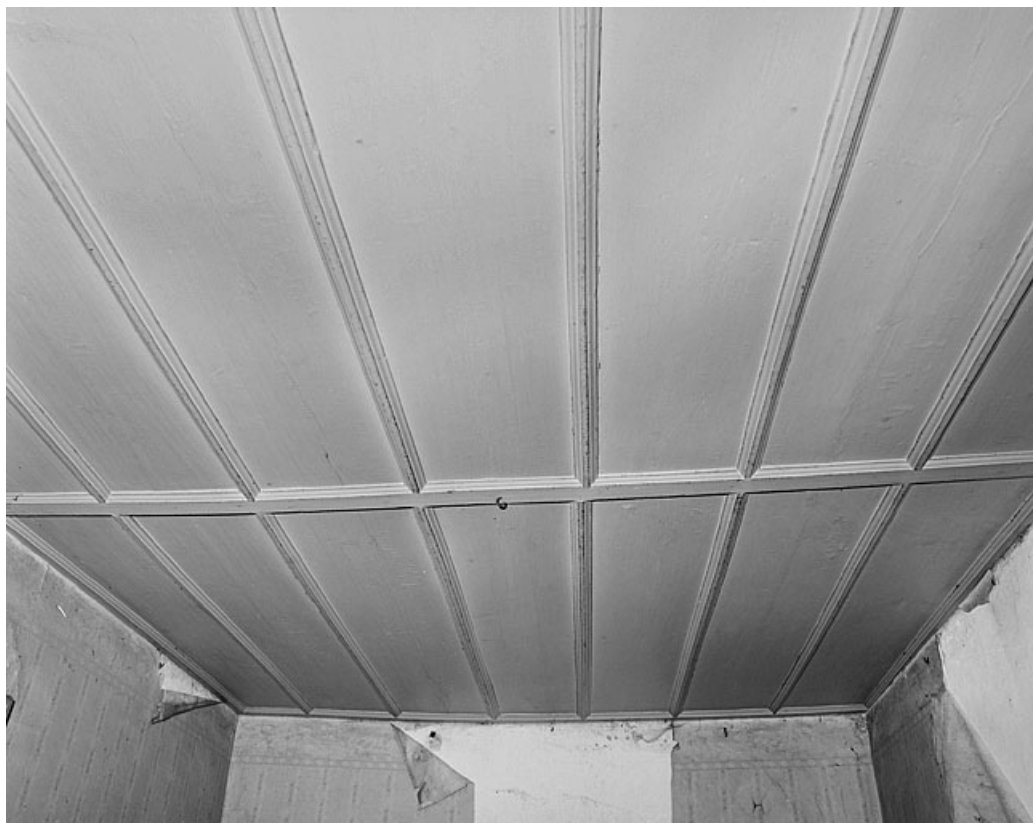
Plafond d'une pièce au premier étage du premier corps de bâtiment.
