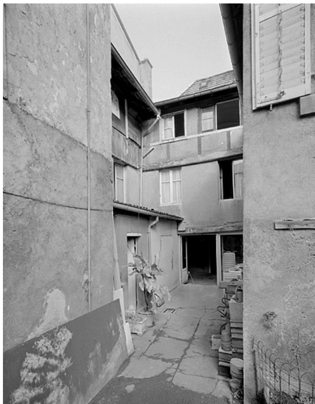
Cour. Au fond la galerie de distribution, à gauche la galerie de liaison. 25, Montbéliard, 8 rue du Général Leclerc
