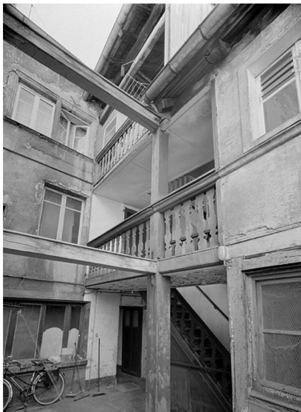
Façade sur cour du premier corps de bâtiment et escalier/galerie. 25, Montbéliard, 13 rue des Febvres
