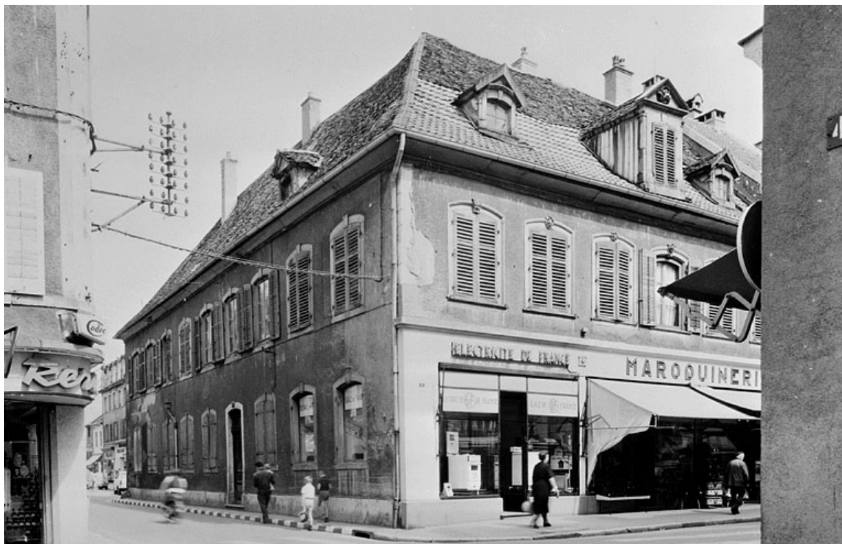
Ensemble des façades sud et ouest avant démolition, vers 1950-1960.
