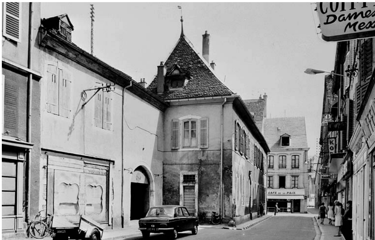
Ensemble de l'aile ouest avant démolition, vers 1950-1960.
