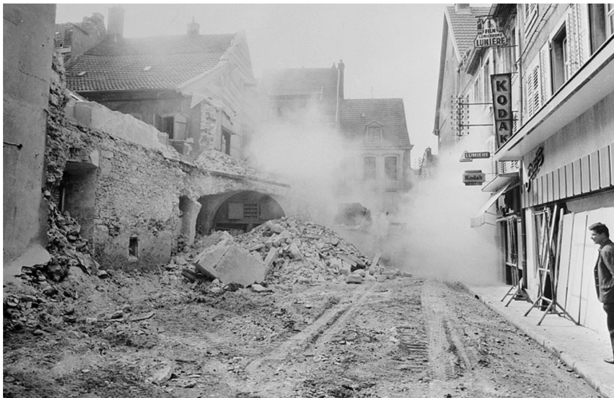
Ensemble de l'aile ouest en cours de démolition, vers 1950-1960.
