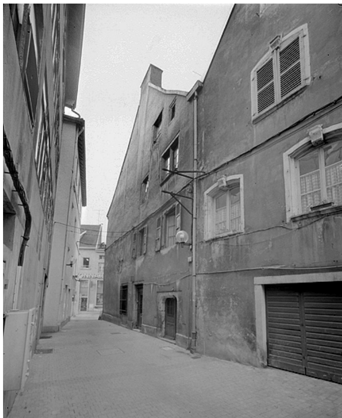
Façade sur la rue Saint-Martin.
