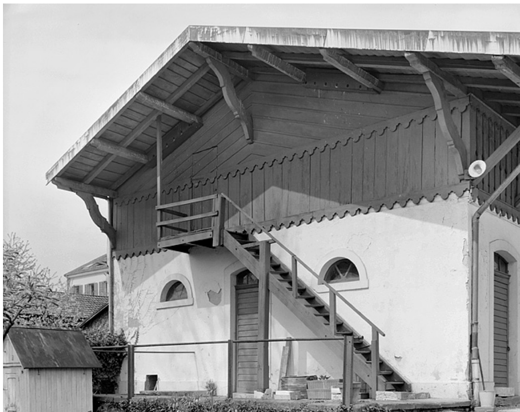
Remise à voitures. Façade sud.
