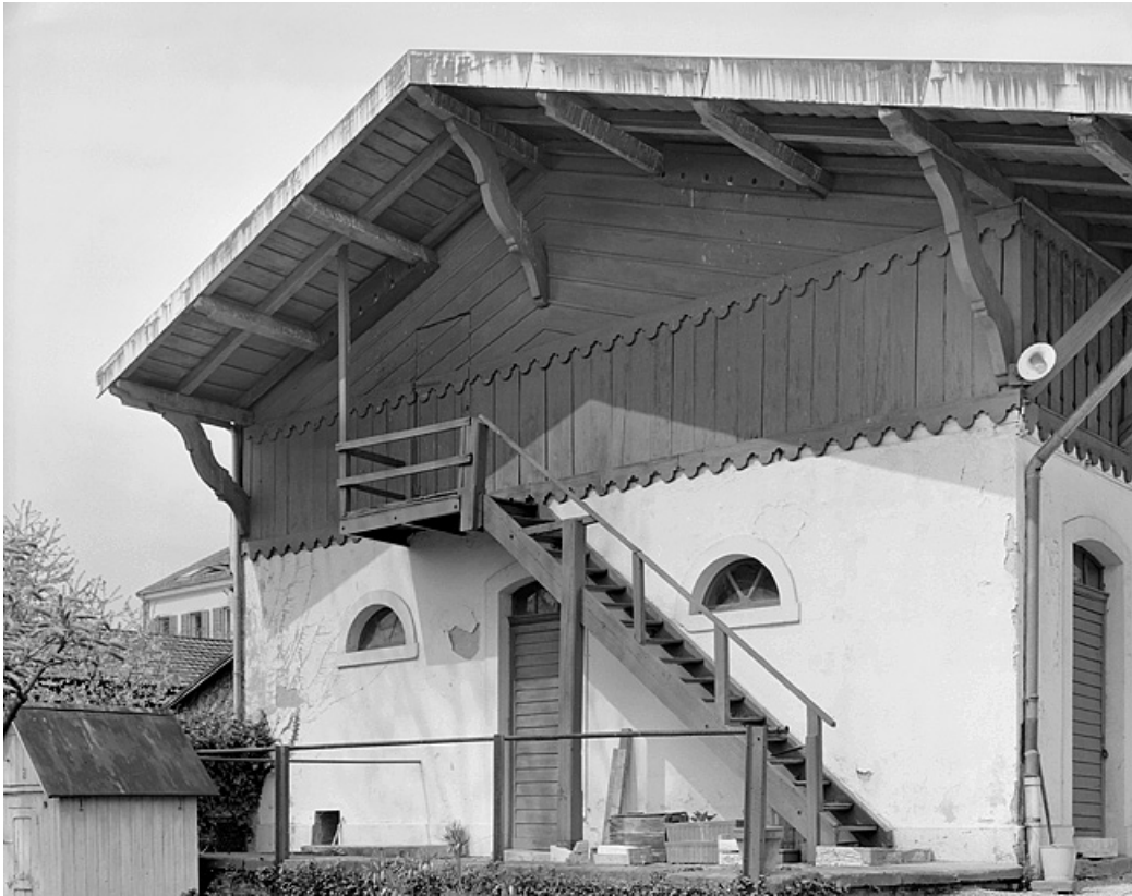
Remise à voitures. Façade sud.
