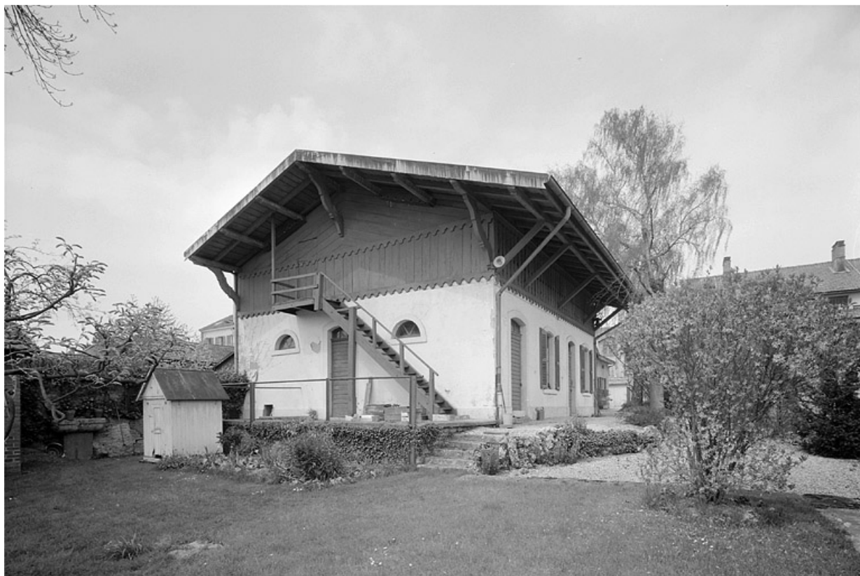
Remise à voitures. Façades sud et est.
