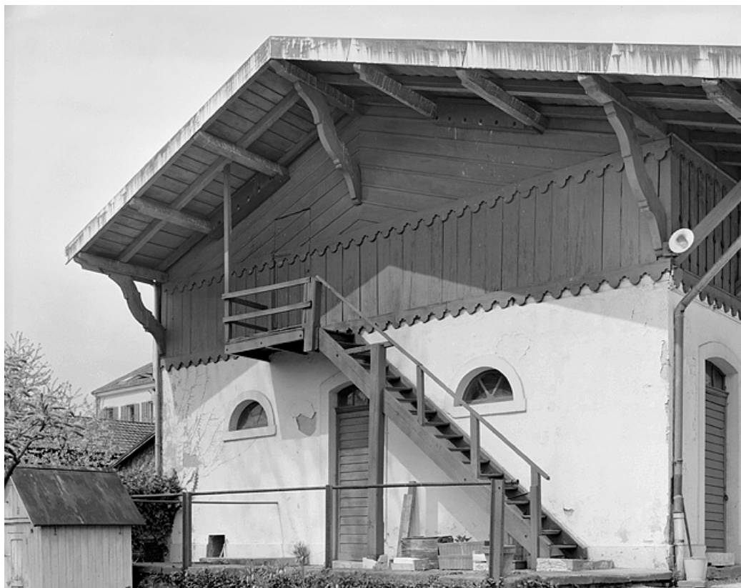
Remise à voitures. Façade sud.
