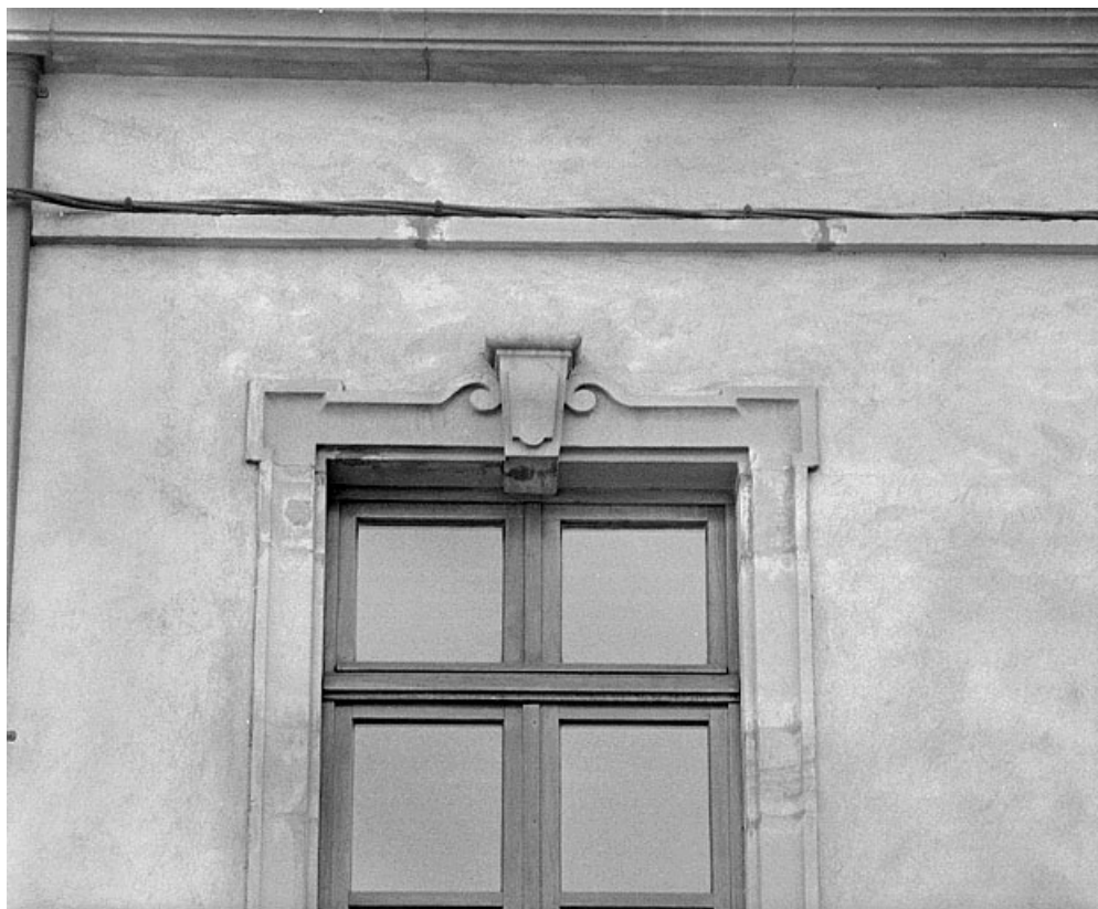
Façade sur rue. Détail de la fenêtre gauche au deuxième étage.
