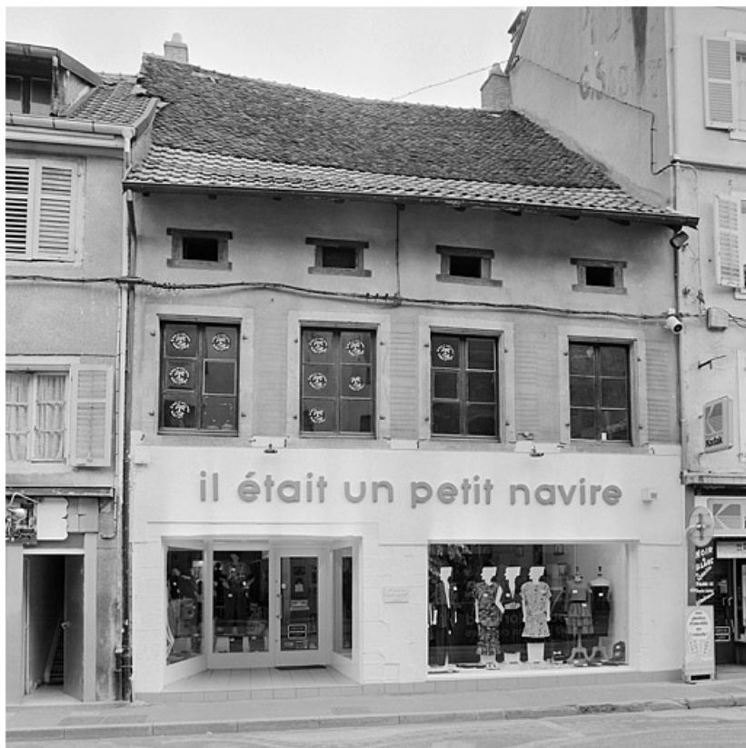
Façade sur la rue Georges Clémenceau du deuxième corps de bâtiment. 25, Montbéliard, 8 place Dorian
