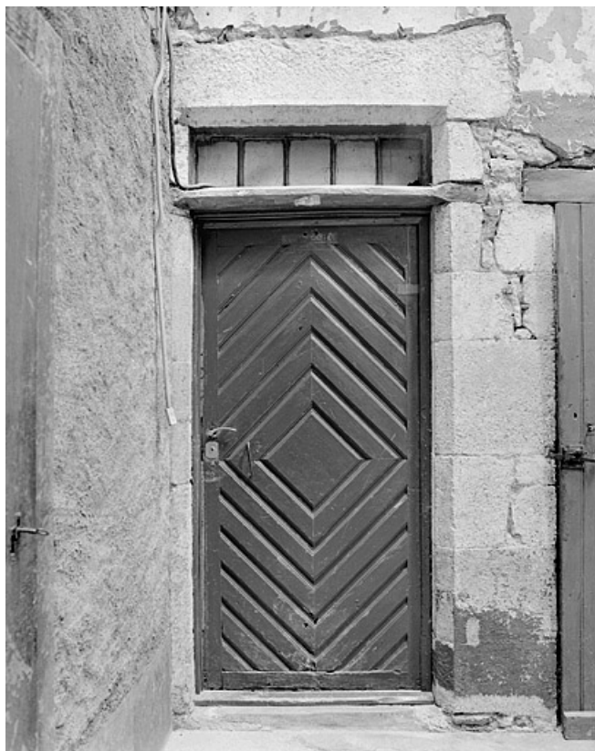
Porte sur cour du deuxième corps de bâtiment.
