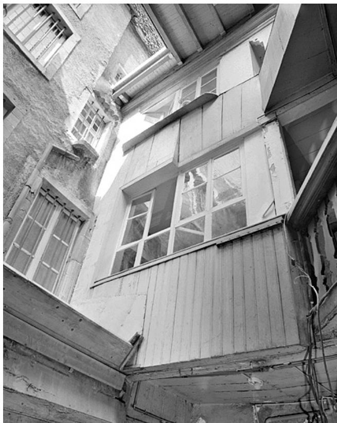
Cour. Galeries de distribution du premier corps de bâtiment.
