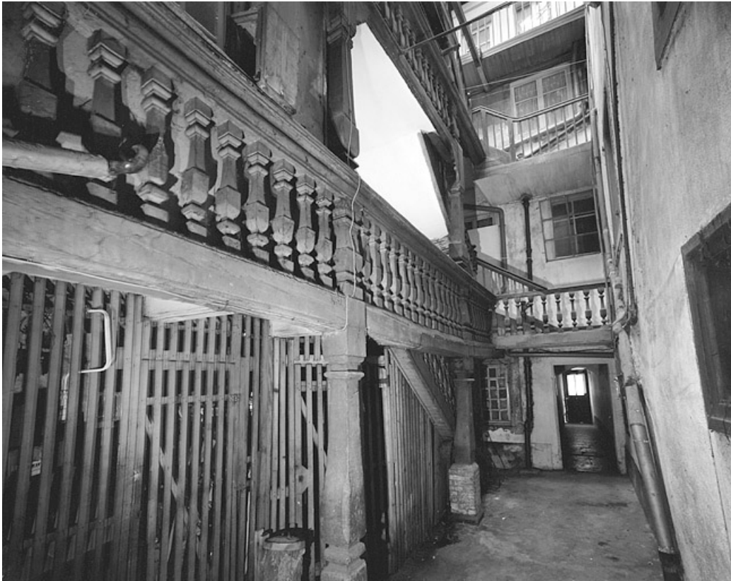
Cour prise en direction du premier corps de bâtiment.
