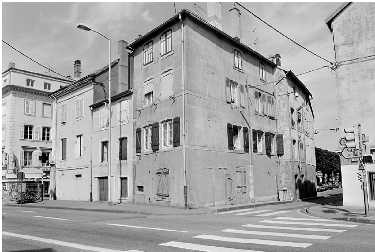
Vue d'ensemble à l'angle des rues Charles-Contejean et Saint-Hippolyte. 25, Montbéliard, 37, 39 place Denfert-Rochereau
