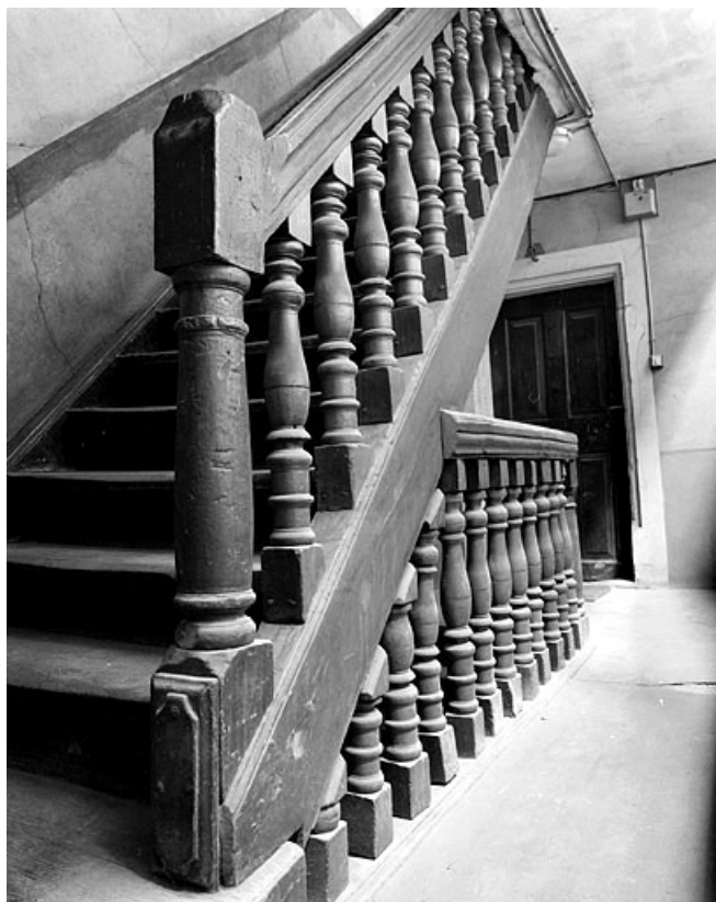
Escalier vu au niveau du premier étage.
