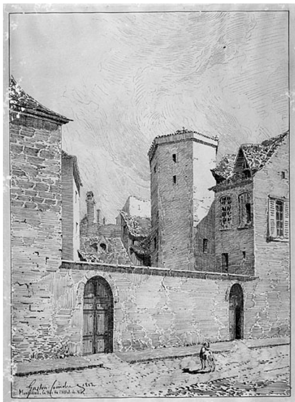
Montbéliard. La rue de l'Hôtel de Ville. Façade sur cour du premier corps de bâtiment de l'ancien hôtel, 1883. 25, Montbéliard, 11 rue Cuvier
