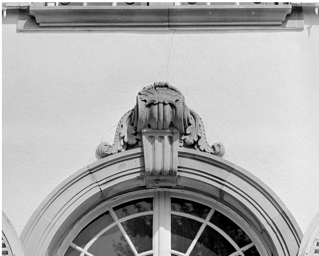
Façade sud. Détail d'une fenêtre du rez-de-chaussée.
