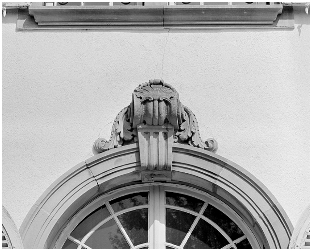
Façade sud. Détail d'une fenêtre du rez-de-chaussée.
