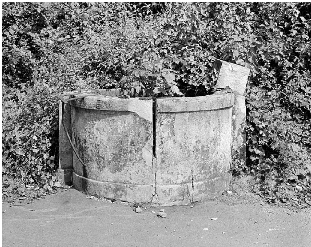
Puits. Il possédait des piédroits, aujourd'hui ruinés, supportant un linteau auquel était accroché la potence. 25, Montbéliard, 12 rue de la Citadelle
