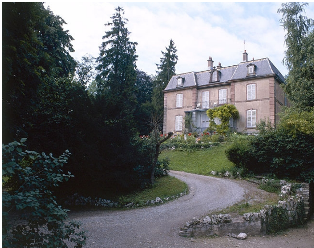
Vue d'ensemble du corps de bâtiment principal.
