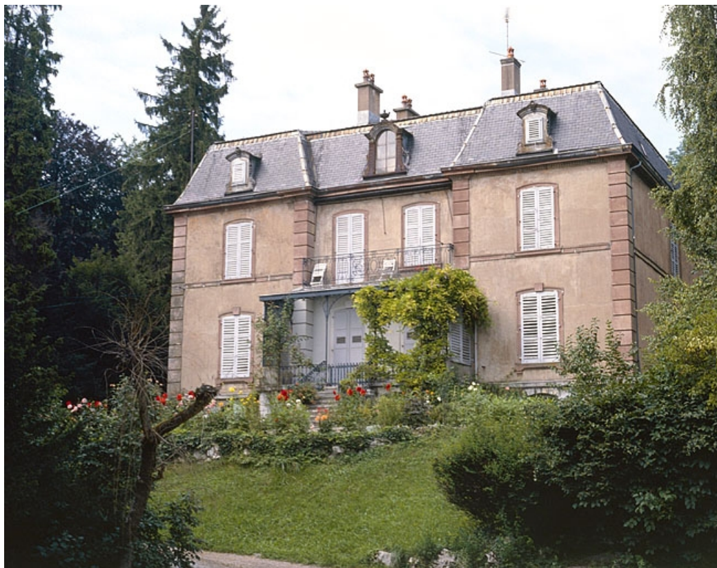
Façade sud du corps de bâtiment principal.
