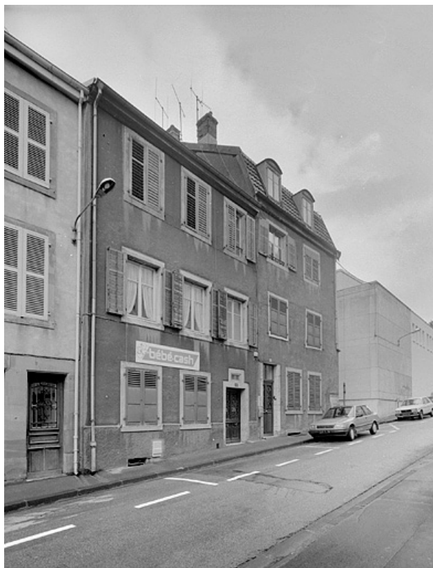
Façade sur la rue du Château. 25, Montbéliard, 9 rue du Château
