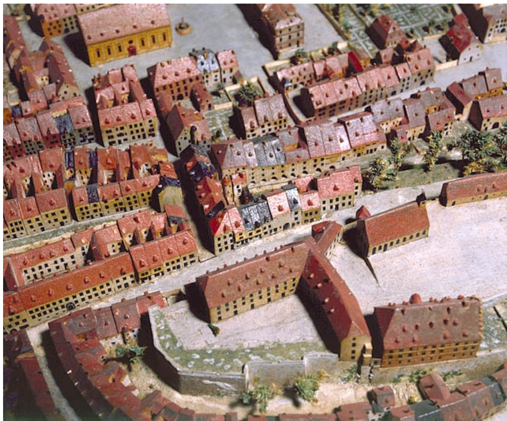
Vue d'ensemble, montrant le corps de bâtiment principal avant sa surélévation d'un étage, 1823-1826. Extrait du plan-relief de 1823-1826, par R.G.I. Wild, échelle 1:1000 (conservé au Musée historique du Vieux Montbéliard).
