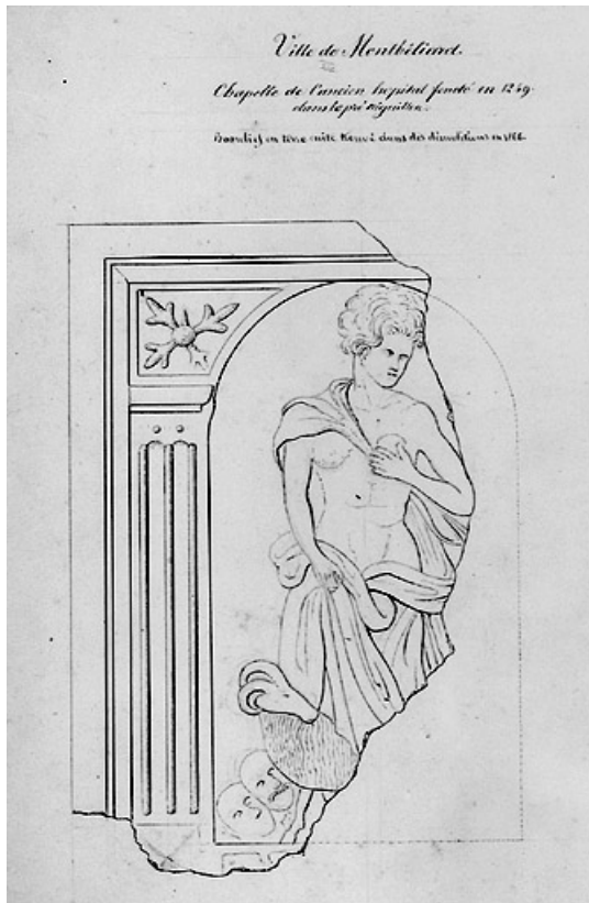
Chapelle. Fragment d'un bas-relief en terre cuite trouvé lors de la démolition, vers 1866.
