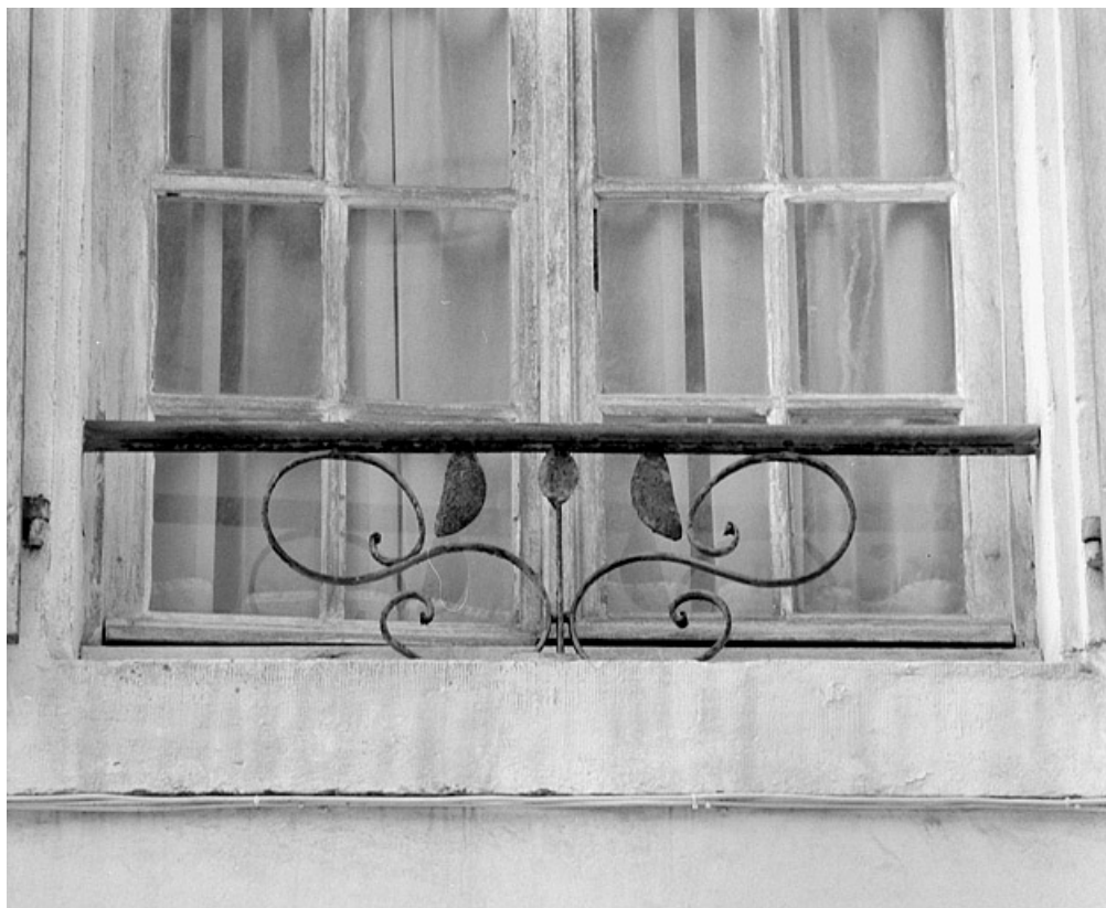
Façade sur rue. Détail d'un balconnet.
