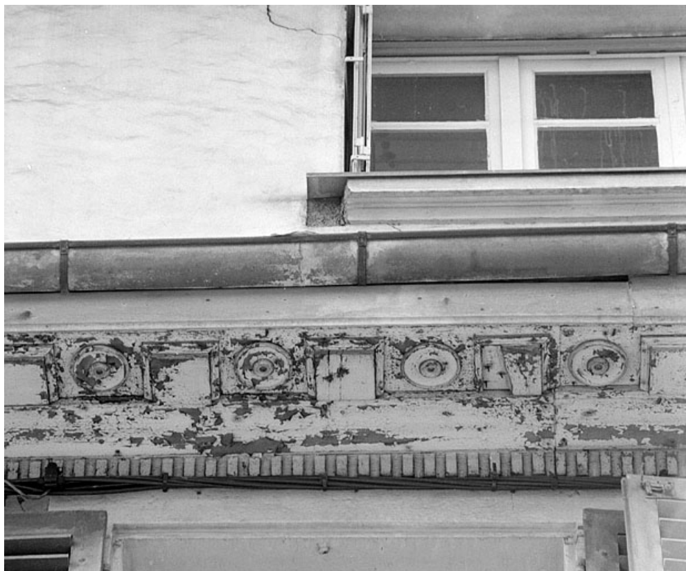
Façade sur rue. Détail de la corniche.
