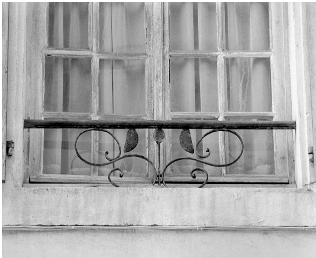
Façade sur rue. Détail d'un balconnet.
