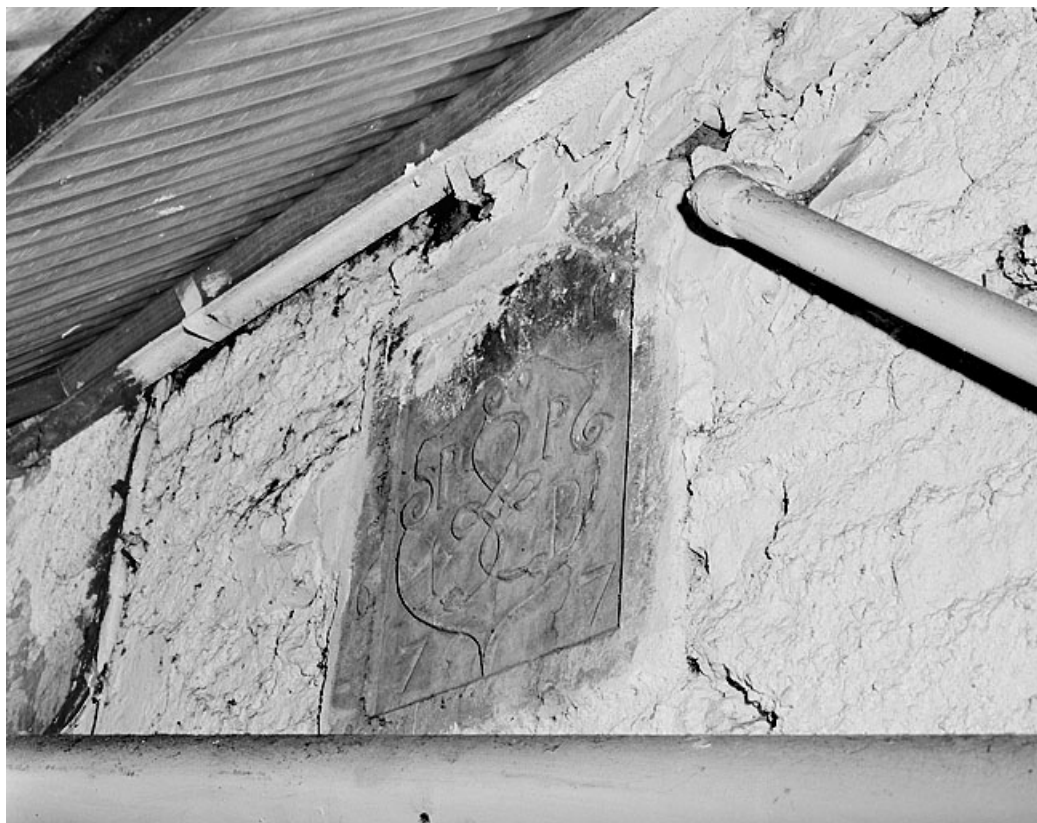
Blason employé sur le bâtiment de 1860, côté ancienne cour. 25, Montbéliard, 18 rue de Belfort
