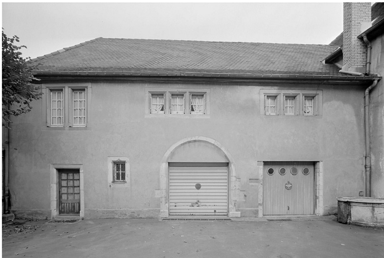
Aile gauche. Façade sur la cour.
