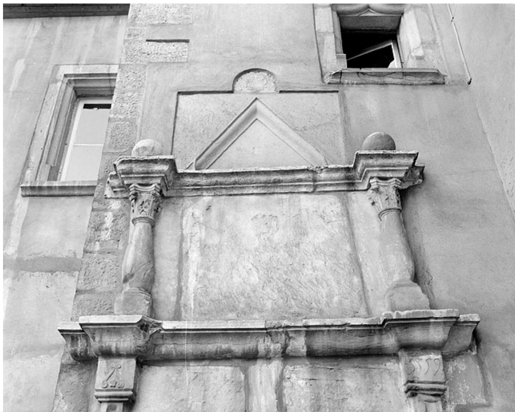
Porte de la tour d'escalier. Détail de la table qui contenait les armes des Franquemont. 25, Montbéliard, 42 rue de Belfort
