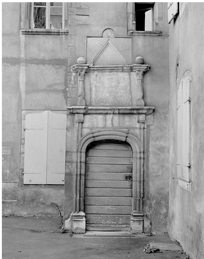
Porte de la tour d'escalier.
