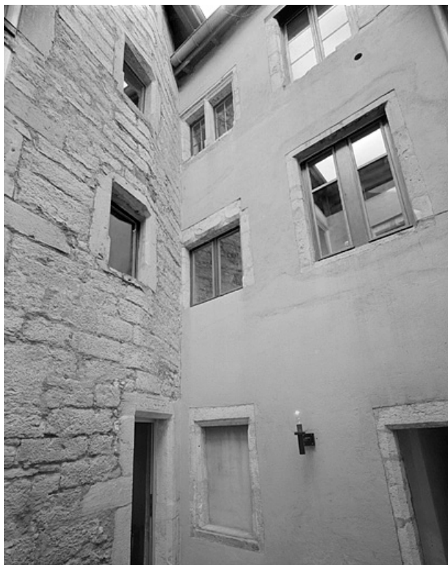
Façade sur cour du premier corps de bâtiment et tour d'escalier. 25, Montbéliard, 21 rue de Belfort
