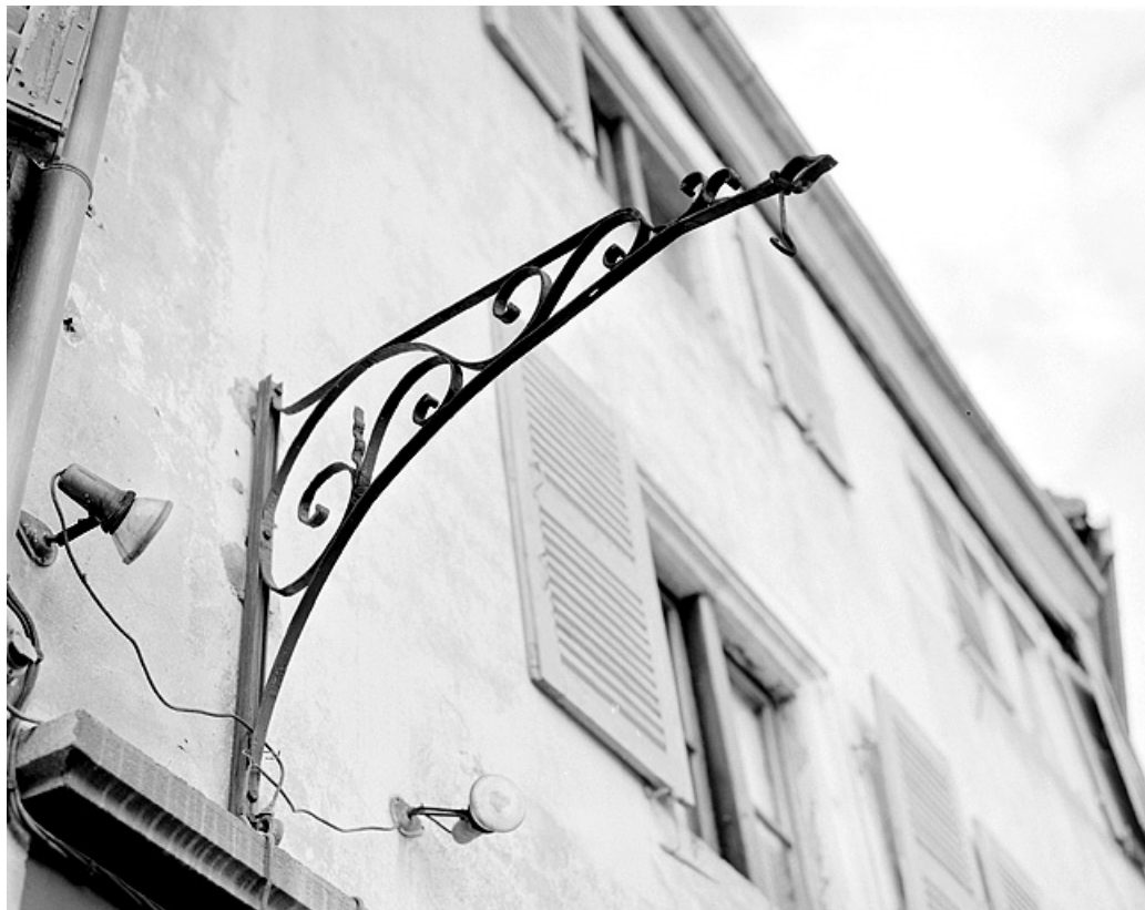
Façade principale, support d'enseigne (19e siècle). 25, Montbéliard, 21 rue de Belfort
