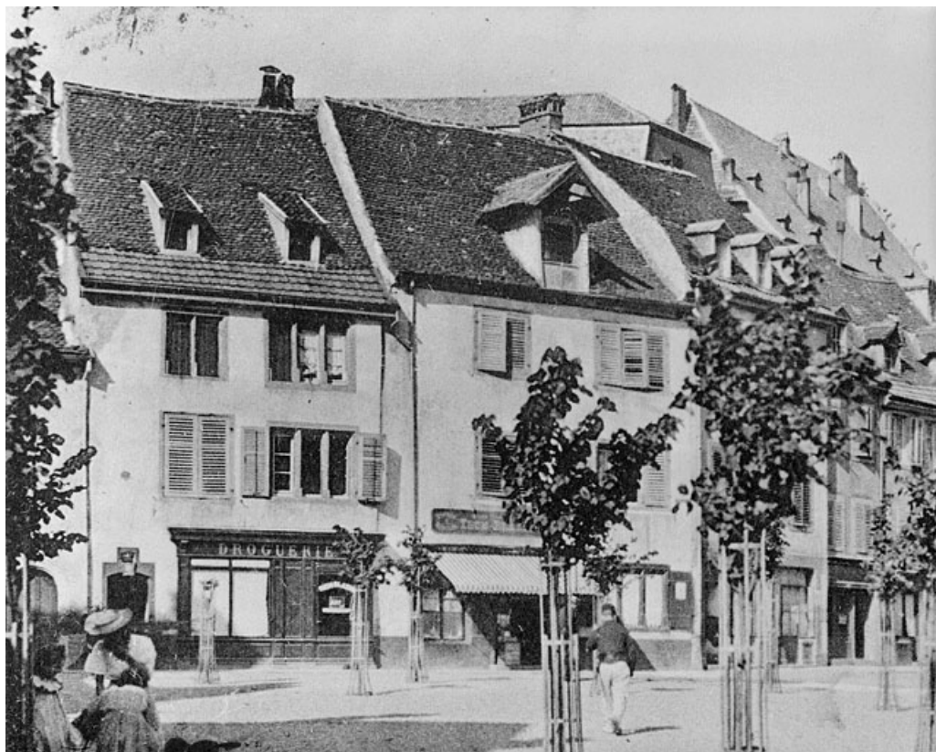
Montbéliard. Le nouveau marché. Place Diemer-Duperret, avant 1908.
