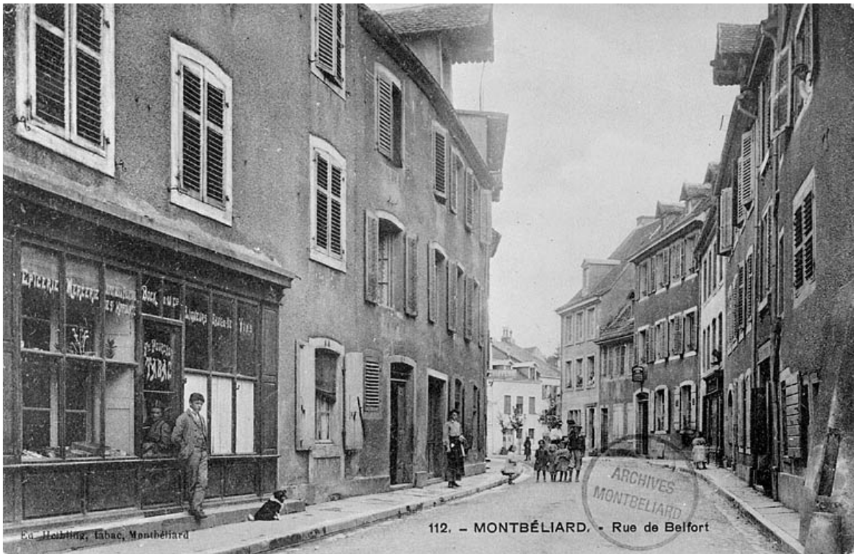
Montbéliard. Rue de Belfort, avant 1915. 25, Montbéliard, 3 rue de Belfort
