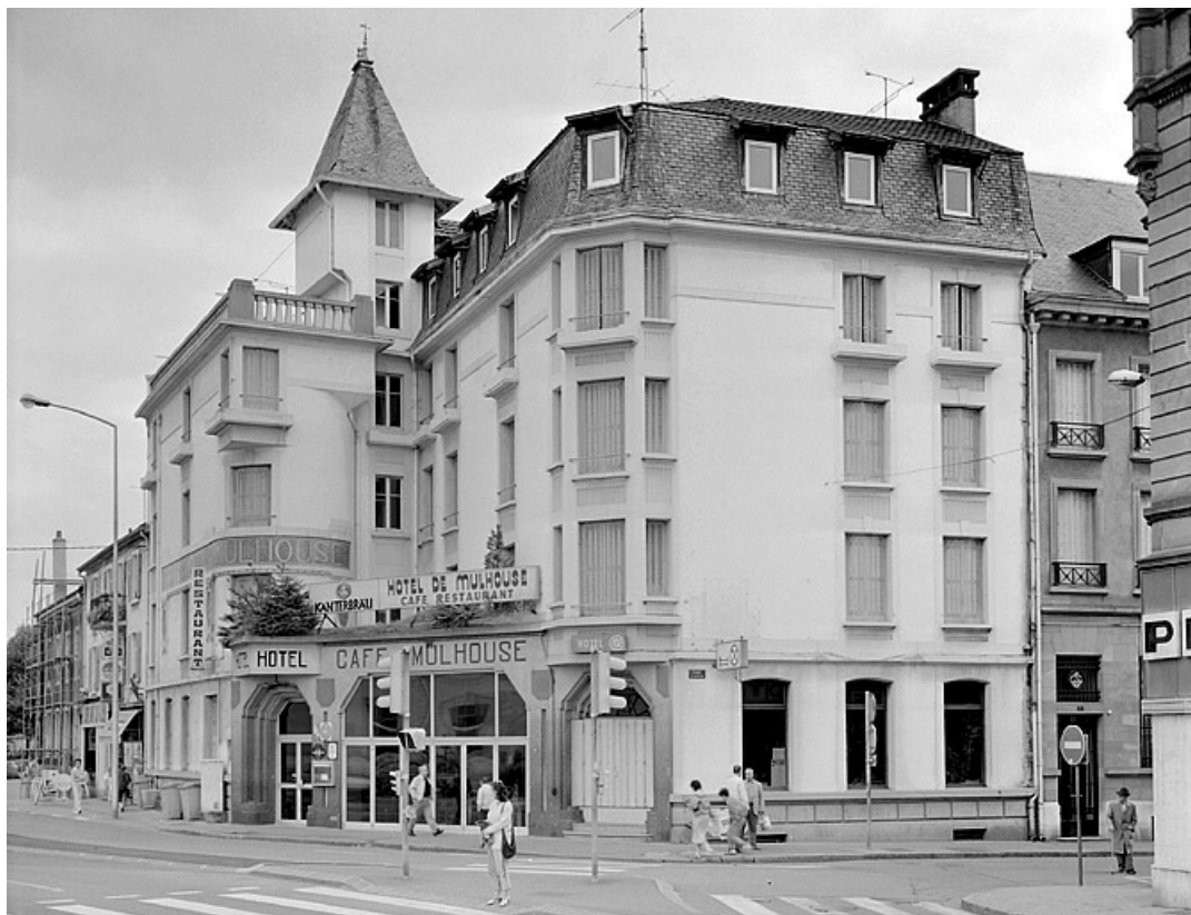
Vue d'ensemble côté rue Cuvier. Le pavillon dominant l'ensemble contient la cage d'ascenseur. 25, Montbéliard, 13 avenue Aristide Briand
