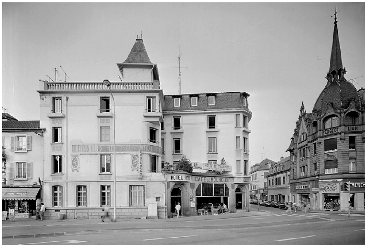
Vue d'ensemble côté place du Général de Gaulle.
