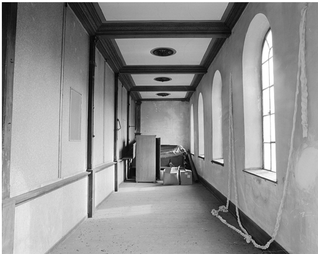
Vue intérieure de la tribune sud.
