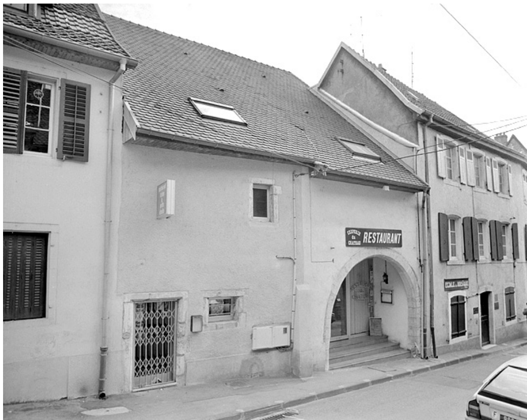
Façade sur rue de la grange et de l'étable. 25, Montbéliard, 6 rue du Château
