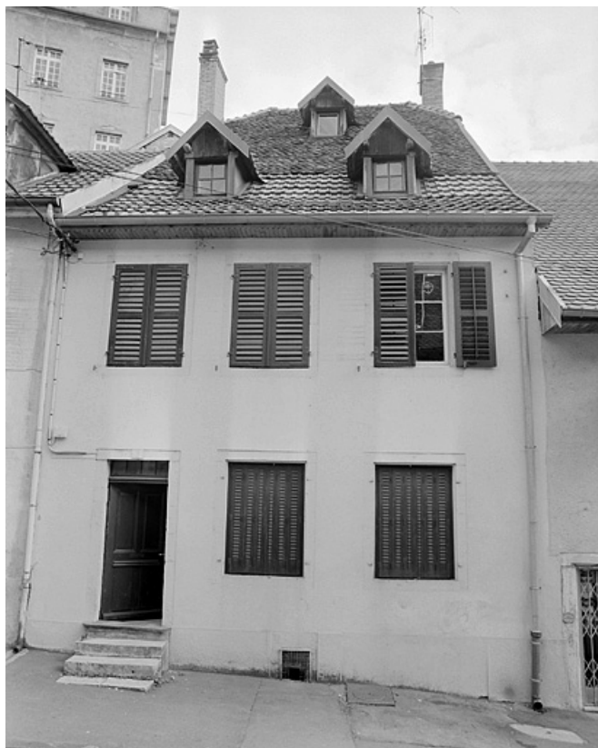
Façade sur rue du corps d'habitation.
