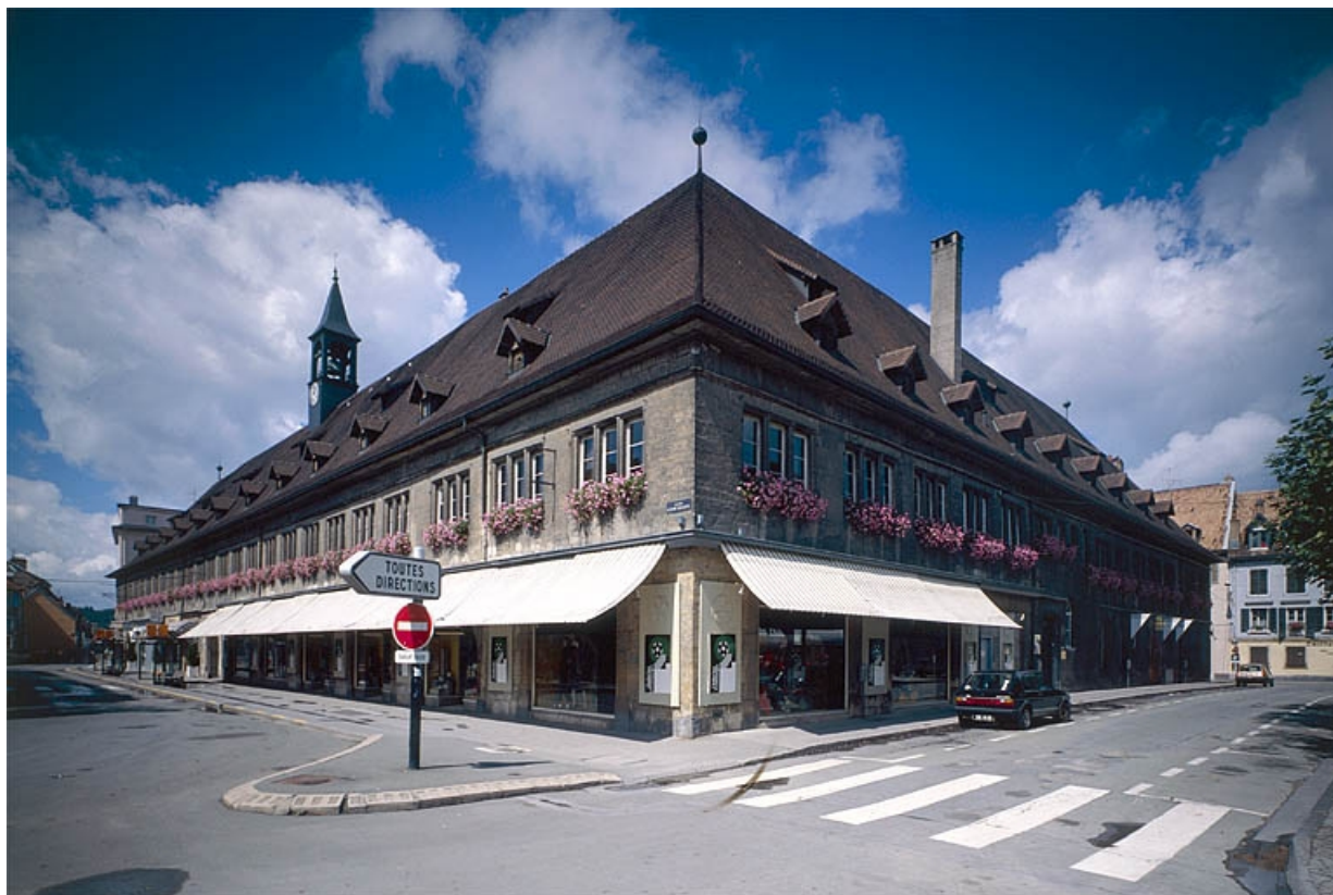
Vue d'ensemble [angle des places Dorian (à droite) et Denfert-Rochereau (à gauche)]. 25, Montbéliard place Denfert-Rochereau
