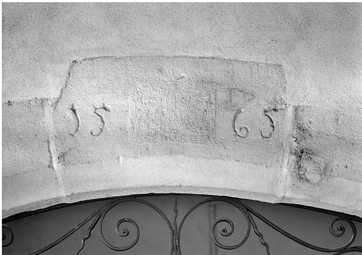
Date sur la porte d'entrée de l'ancienne douane à l'intérieur de l'aile est. 25, Montbéliard place Denfert-Rochereau
