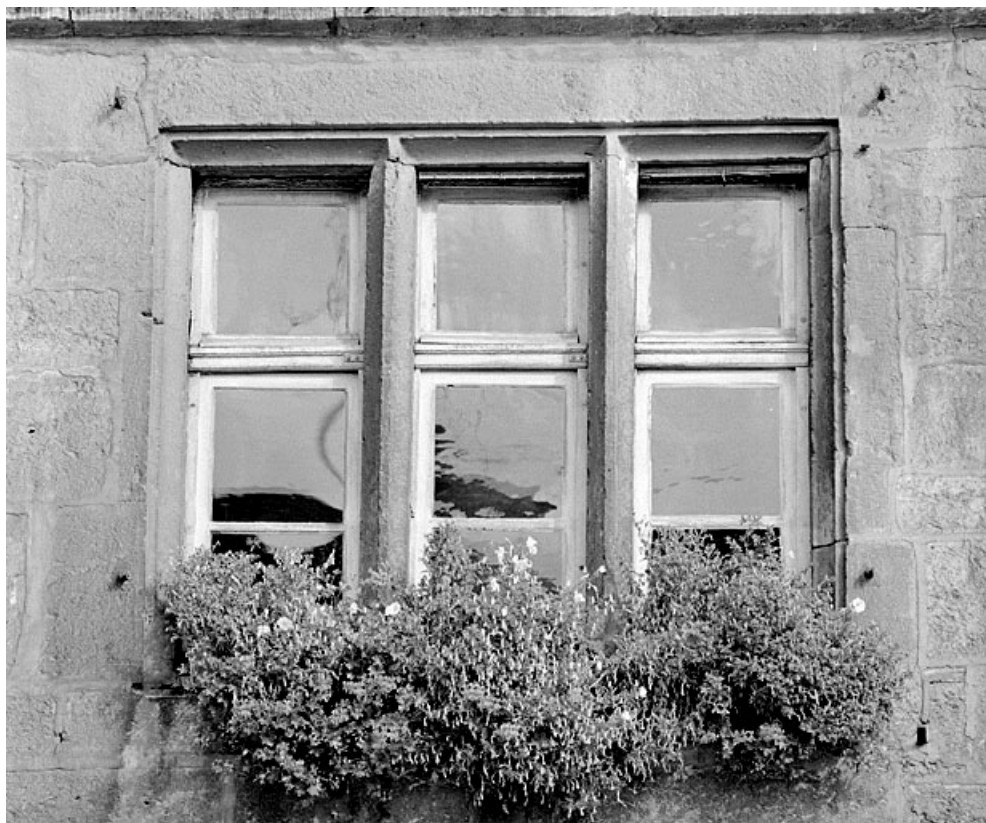
Façade principale [détail d'une fenêtre du premier étage].
