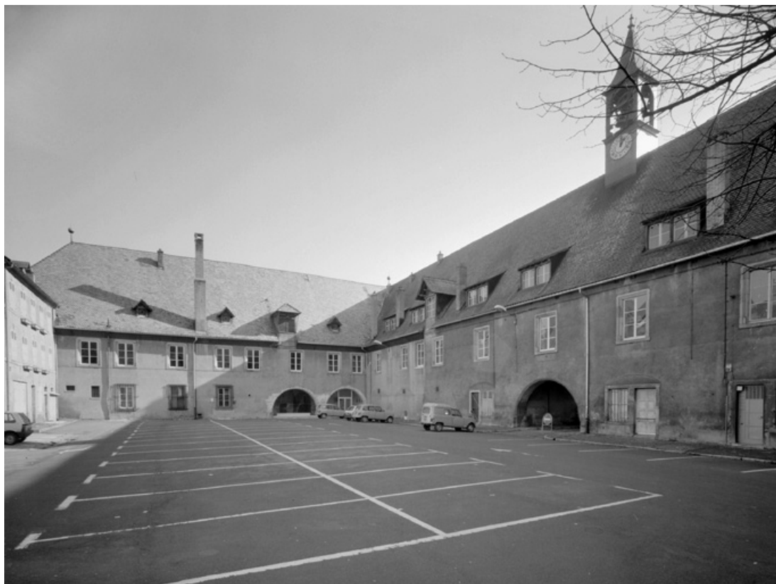
Cour [corps de bâtiment principal à droite et aile est au fond].
