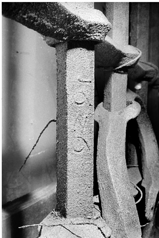
Détail de la grille de droite de l'ancien grenier à blé. 25, Montbéliard place Denfert-Rochereau
