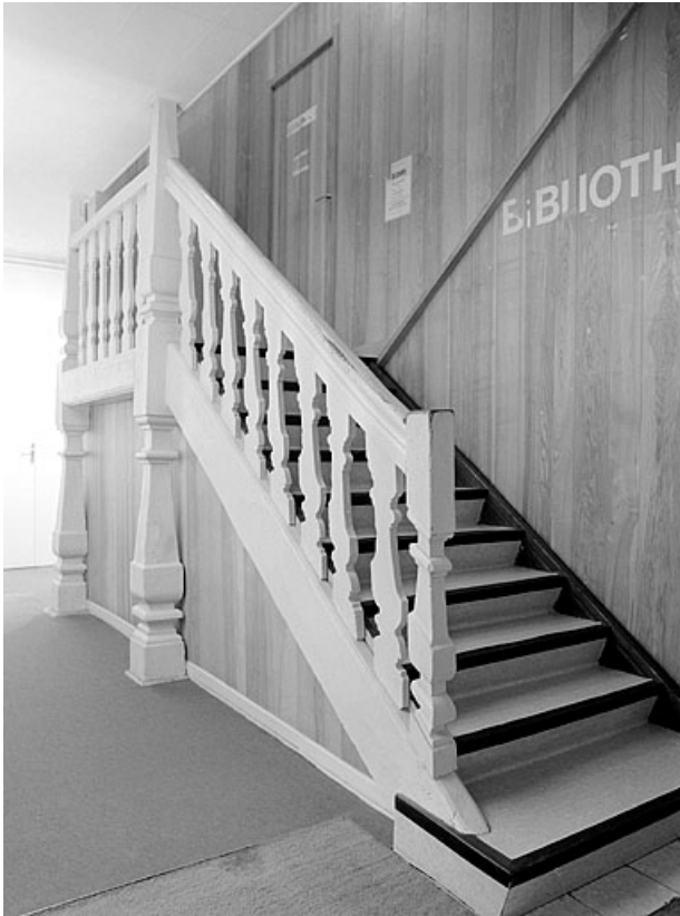
Escalier de la galerie de liaison [pris au niveau du rez-de-chaussée surélevé]. 25, Montbéliard, 1 rue du Château
