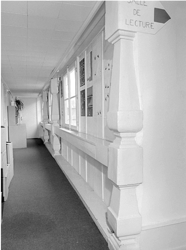
Galerie de distribution [au niveau du premier étage, partie orientale]. 25, Montbéliard, 1 rue du Château
