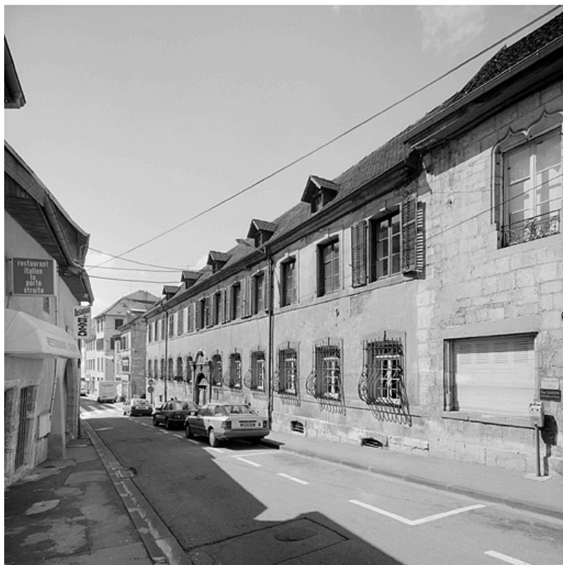
Façade sur la rue du Château. 25, Montbéliard, 1 rue du Château
