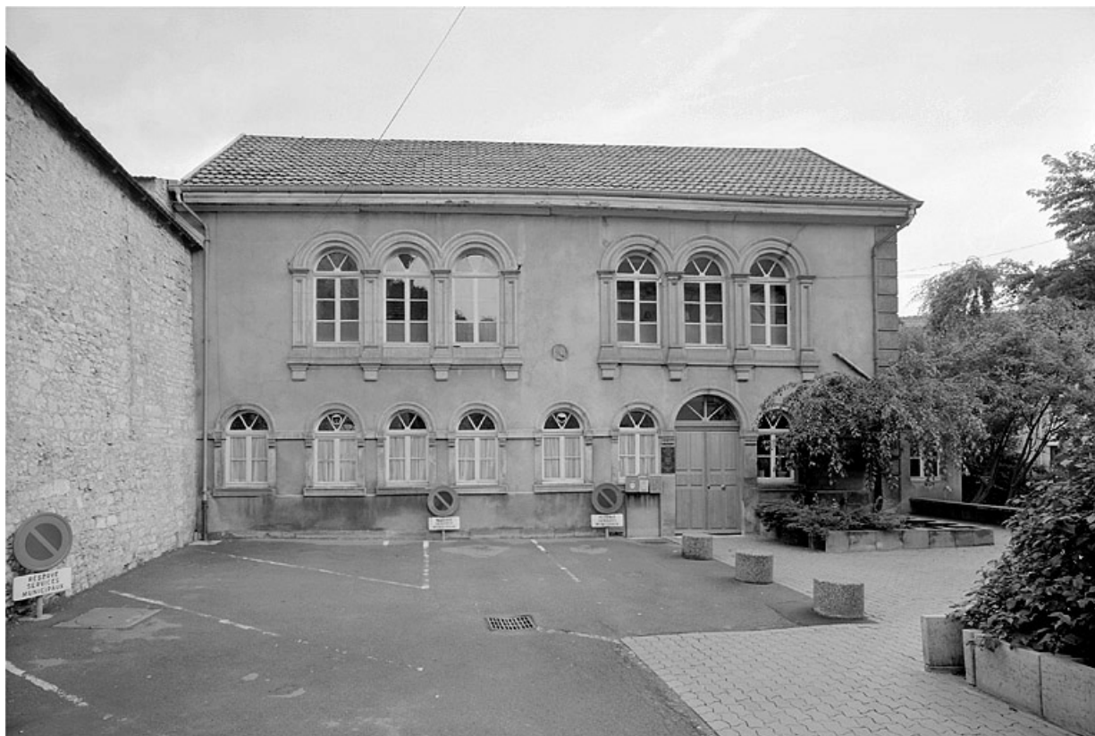
Bâtiment des Bains. Façade sur cour.
