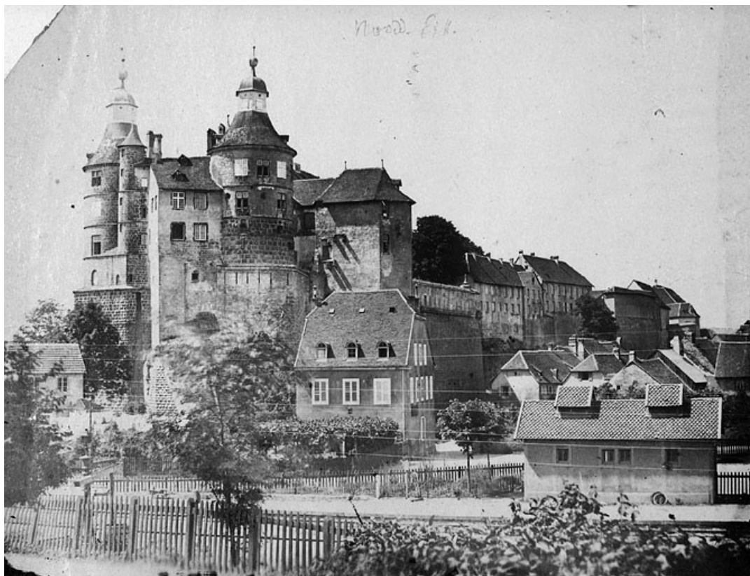
Vue de la partie nord-est du Neuf Château, 3e quart 19e siècle. 25, Montbéliard cour du Château
