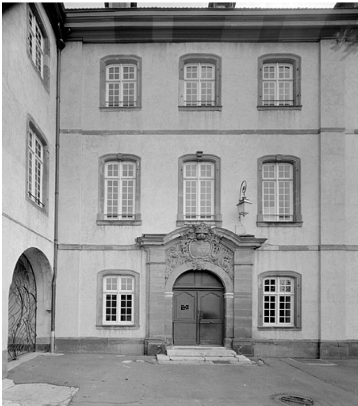
Corps de bâtiment principal. Partie gauche de la façade sur cour. 25, Montbéliard cour du Château
