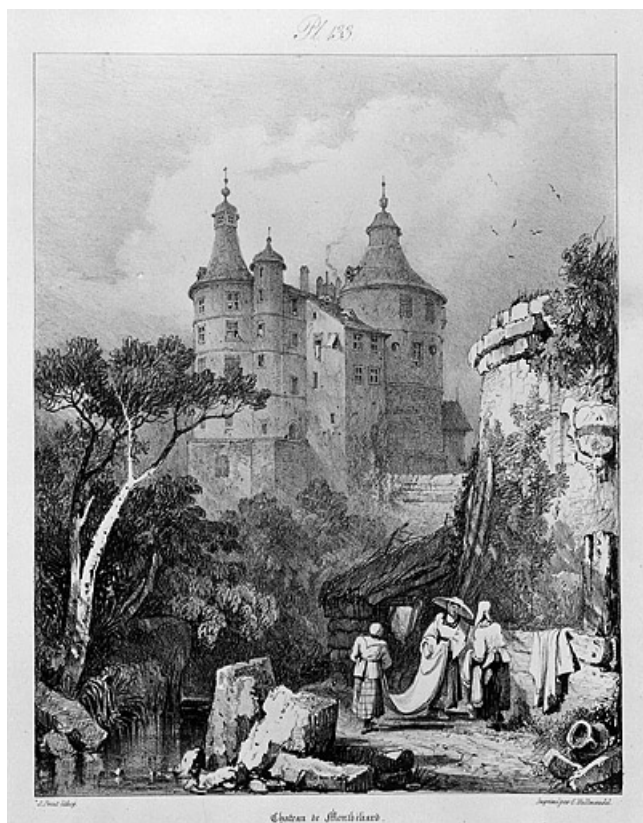
Château de Montbéliard [vue des tours depuis le Fort Le Chat], 1825. 25, Montbéliard cour du Château
