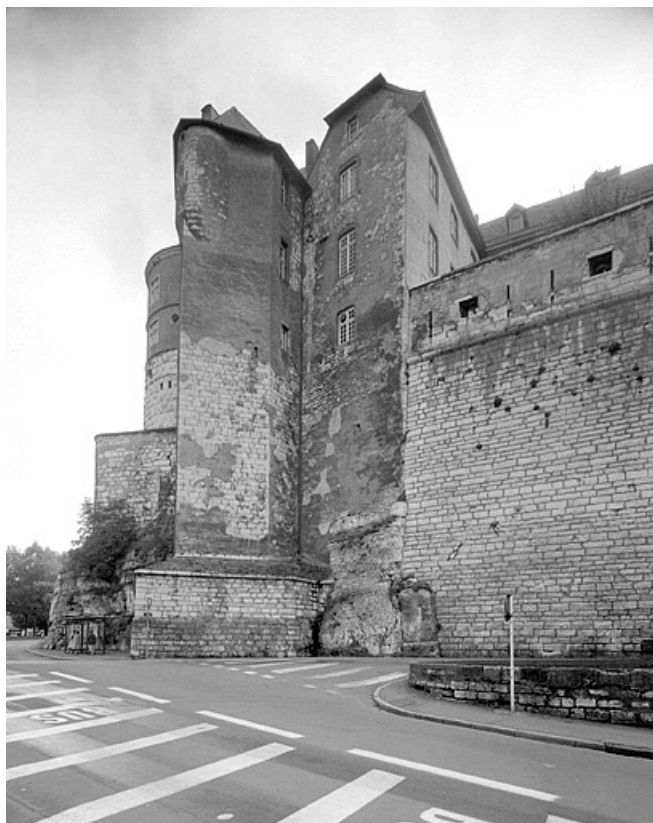
Tour en éperon et aile en retour du corps de logis principal. 25, Montbéliard cour du Château
