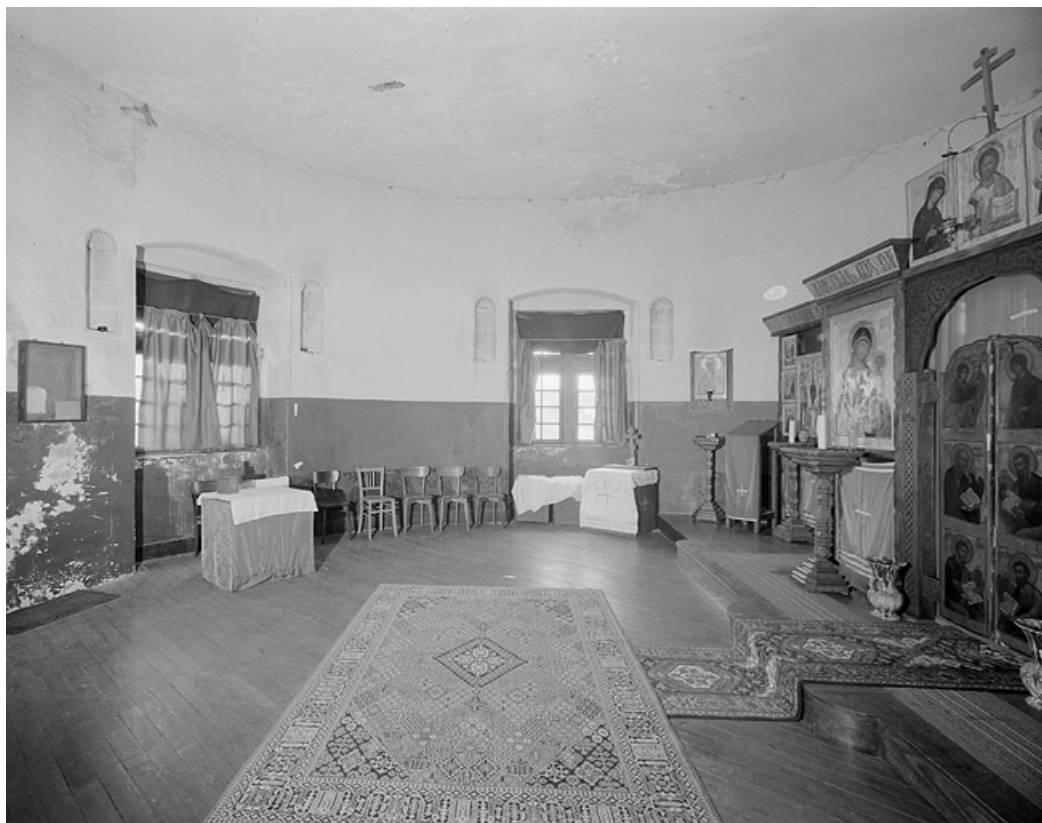
Tour Henriette. Pièce du cinquième niveau aménagée en église orthodoxe. 25, Montbéliard cour du Château
