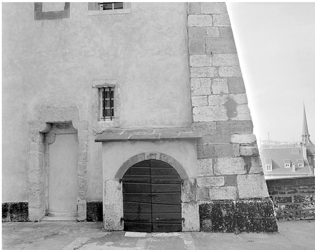
Façade sur la cour de l'Ours de la tour en éperon. À gauche, ancienne entrée de la salle du rez-de-chaussée ; à droite, porte ouvrant sur un escalier droit conduisant à la salle du puits.
