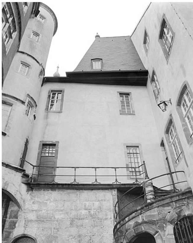
Cour de l'Ours. Coursière reliant la tour Henriette au corps de bâtiment principal. 25, Montbéliard cour du Château
