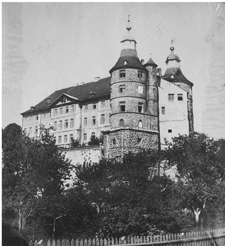
Vue de la partie sud-est du Neuf Château, 3e quart 19e siècle.
