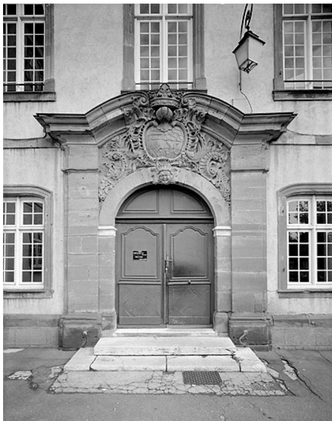
Portail du corps de bâtiment principal. 25, Montbéliard cour du Château
