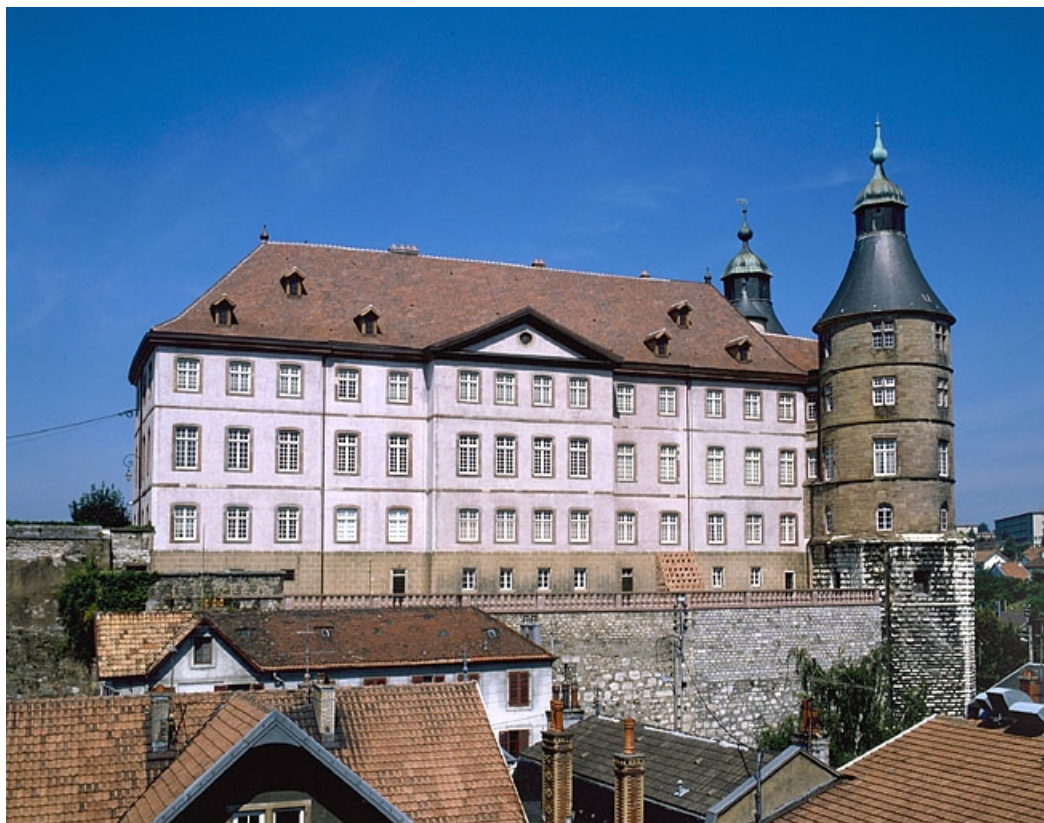
Corps de bâtiment principal. Côté sud. 25, Montbéliard cour du Château
