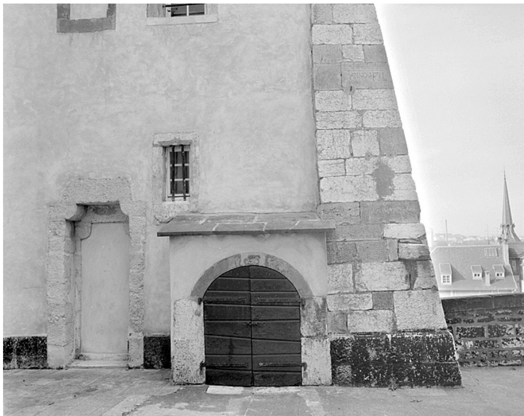
Façade sur la cour de l'Ours de la tour en éperon. À gauche, ancienne entrée de la salle du rez-de-chaussée ; à droite, porte ouvrant sur un escalier droit conduisant à la salle du puits.
