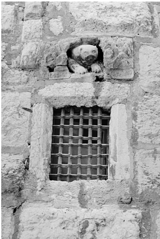
Tour Henriette. Détail de l'ours et de la fenêtre du deuxième niveau. 25, Montbéliard cour du Château
